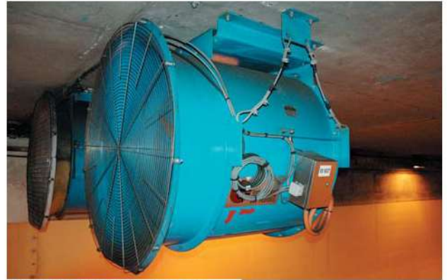
Tunnel du Quai Bellevue à Lyon
