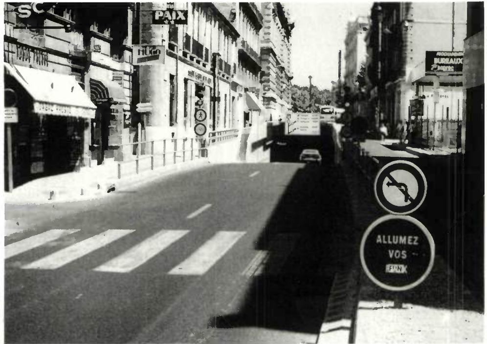
Tunnel de la place de La Comédie à Montpellier, Hérault
