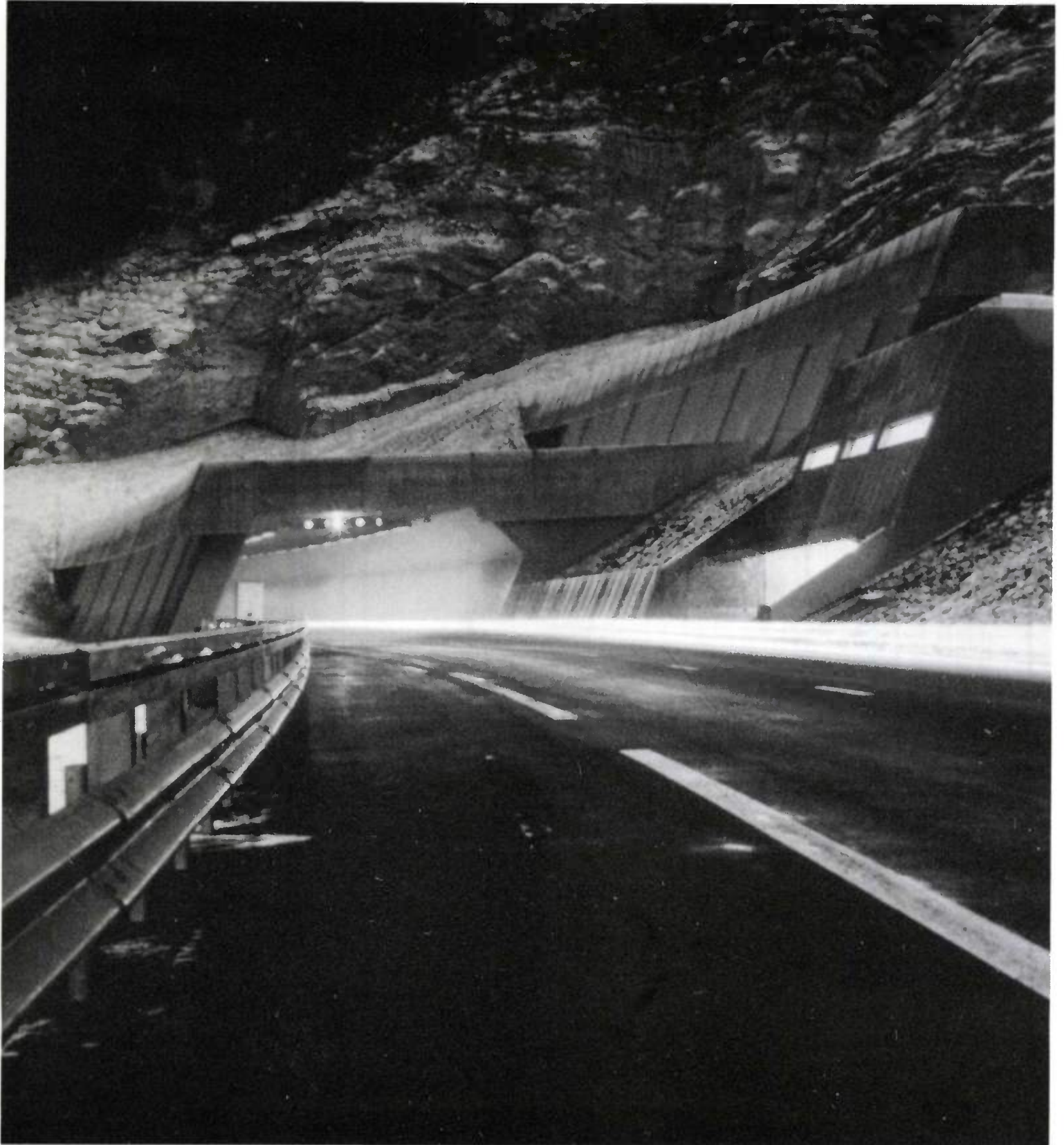
Tunnel de Châtillon, Ain
