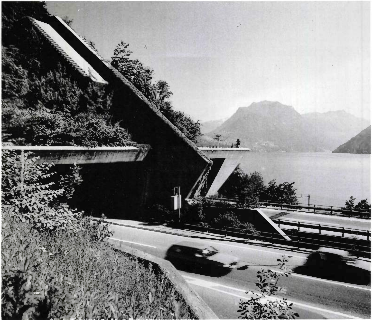
Tunnel de l'Autoroute du Tessin (Suisse)
