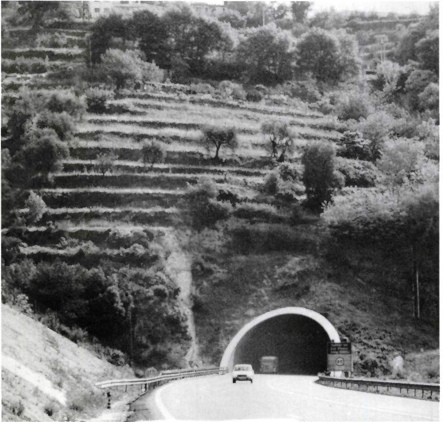
Le tunnel de Las Planas, Alpes-Maritimes
