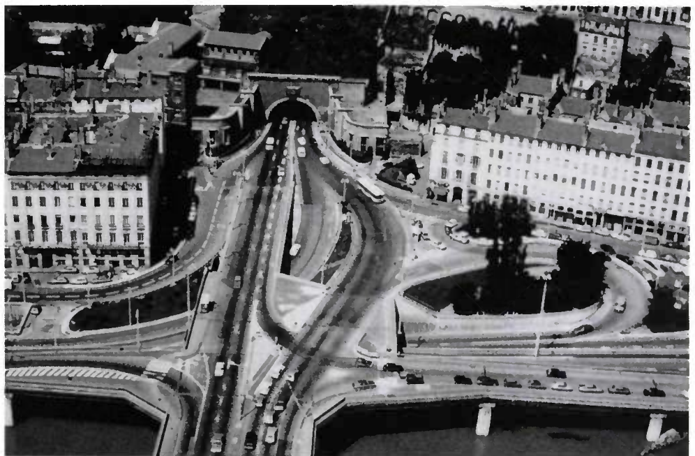
Le tunnel de la Croix Rousse à Lyon
