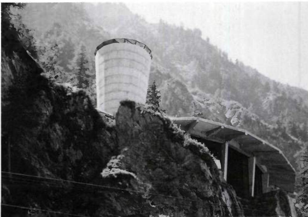
Cheminée de ventilation du tunnel du Fréjus, Savoie
