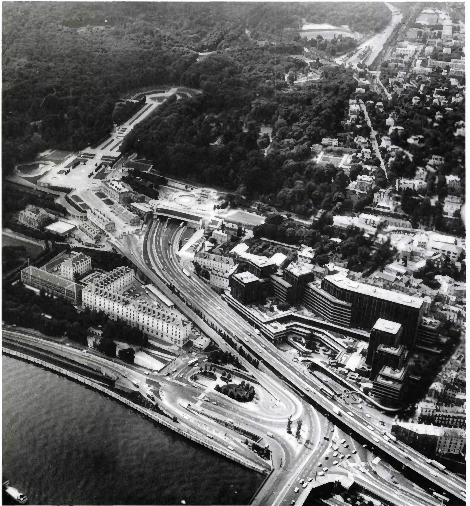
Vue aérienne du tunnel de St-Cloud, Hauts de Seine
