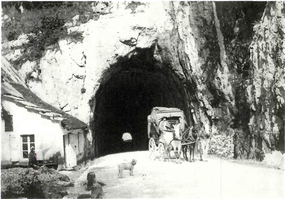
Tunnel des Echelles, Savoie
