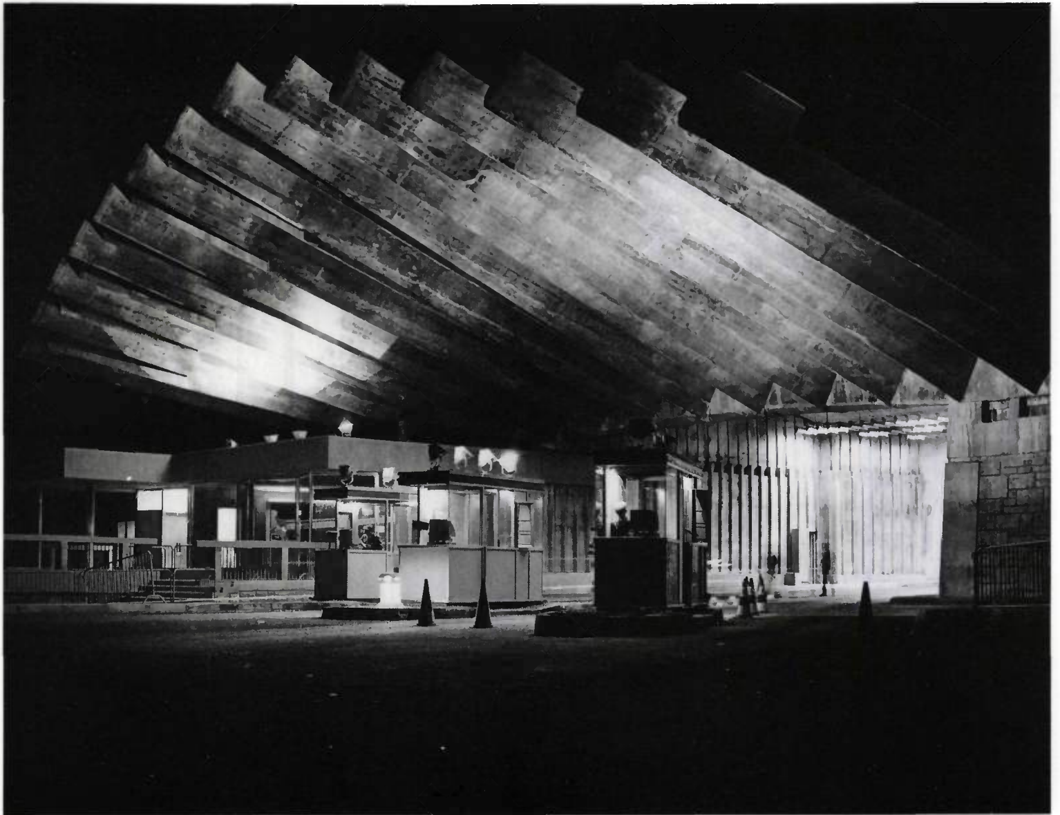
L'entrée française du tunnel (état initial)
