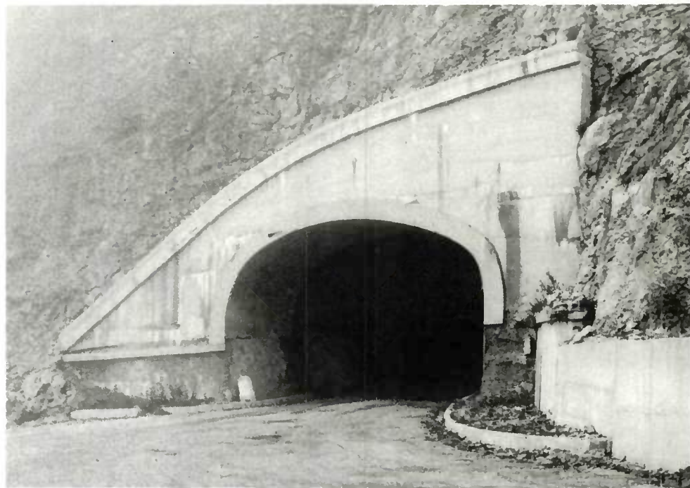
Un soutènement au tunnel du Pas du Mortier, Isère
