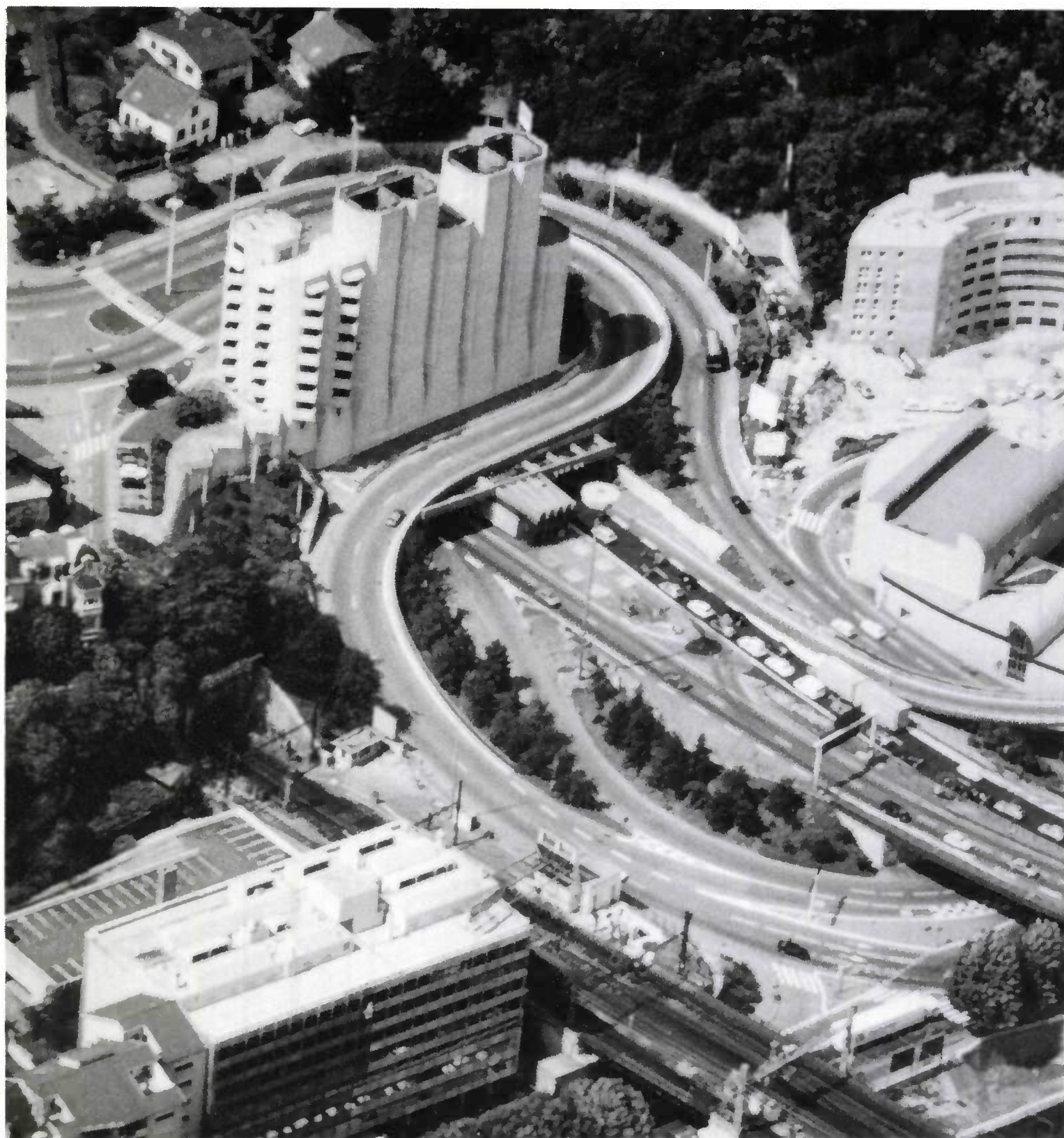
TUNNEL SOUS FOURVIÈRE - VUE AÉRIENNE DE LA TÊTE DE SAÔNE
