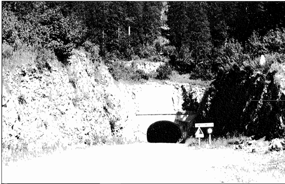
Fig. 14. – Tunnel du Pas du Mortier côté Autrans.
