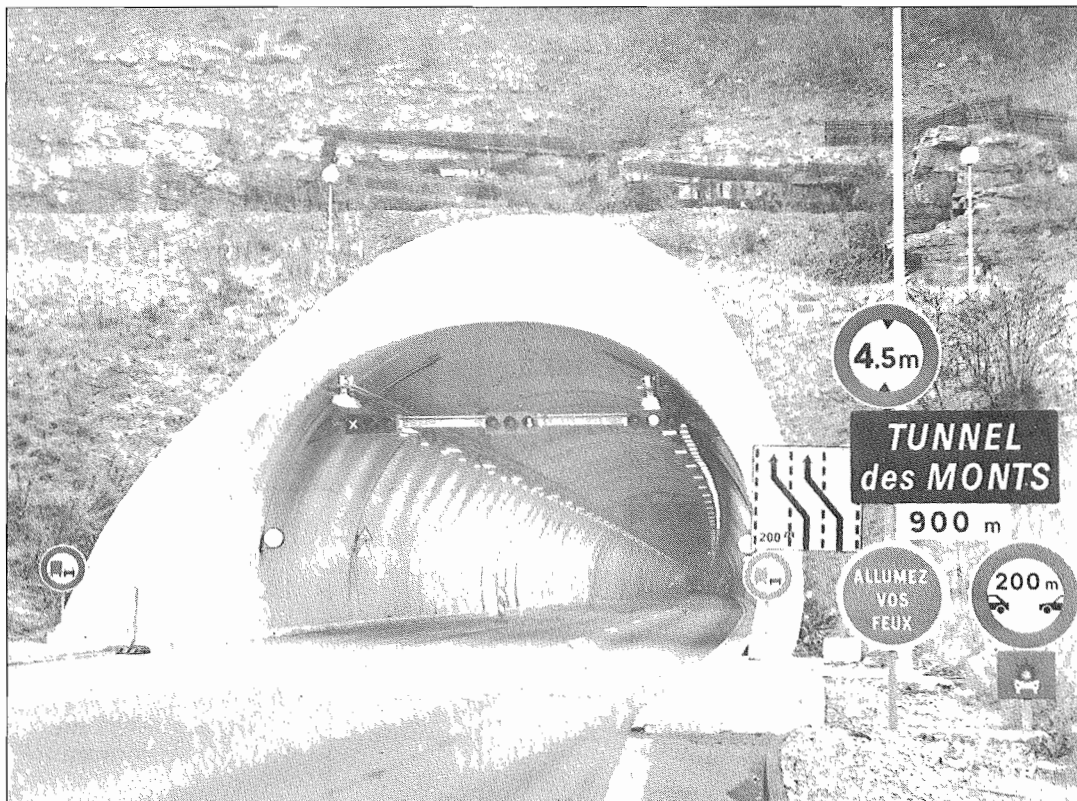
Tunnel des Monts – Tube Sud – Tête Ouest.
