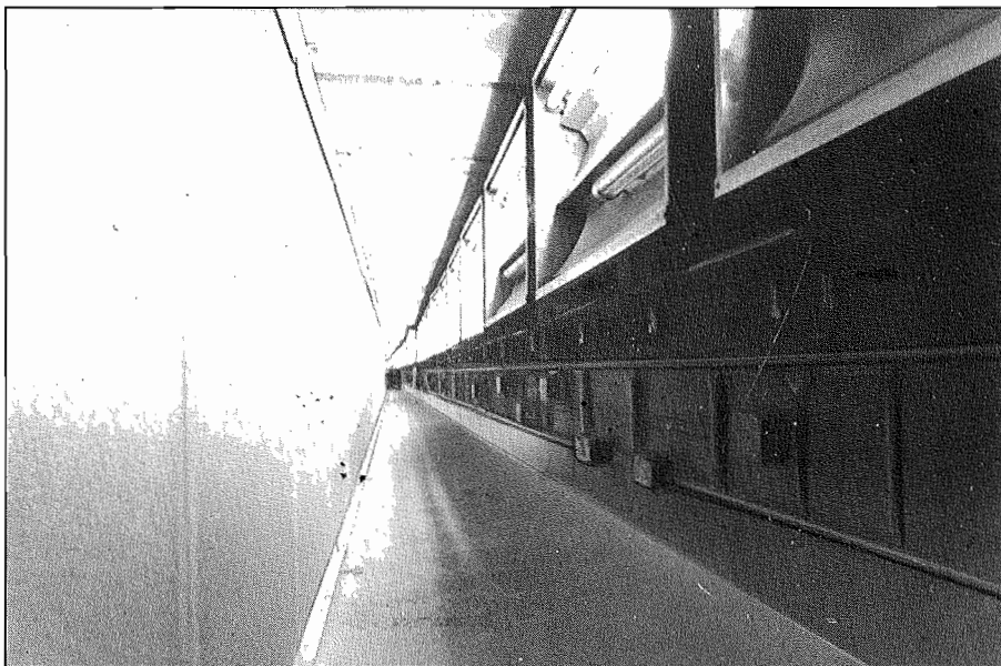
Fig. 84. – Tunnel du Maine. Intérieur de la galerie d'éclairage.
