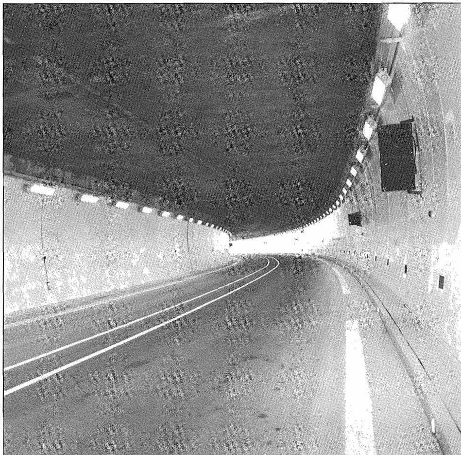
Tunnel du Fréjus — Tête France — Fin de la zone de renforcement.
