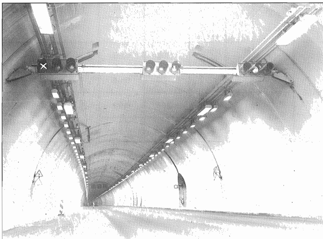
Tunnel des Monts – Zone de renforcement.
