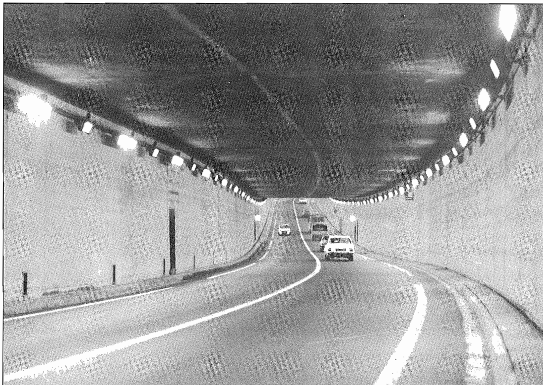
Tunnel de Bastia. — Eclairage bilatéral dans la zone de section courante à profil cadre.
