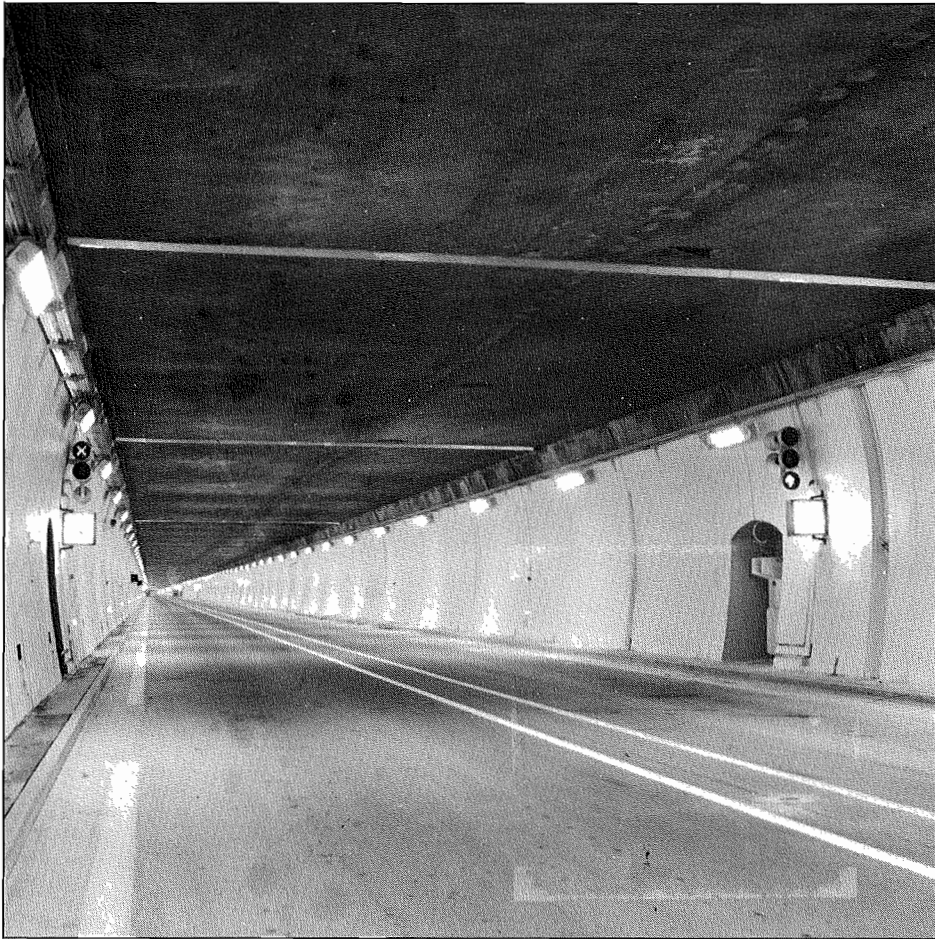
Tunnel du Fréjus — Début de la section courante.
