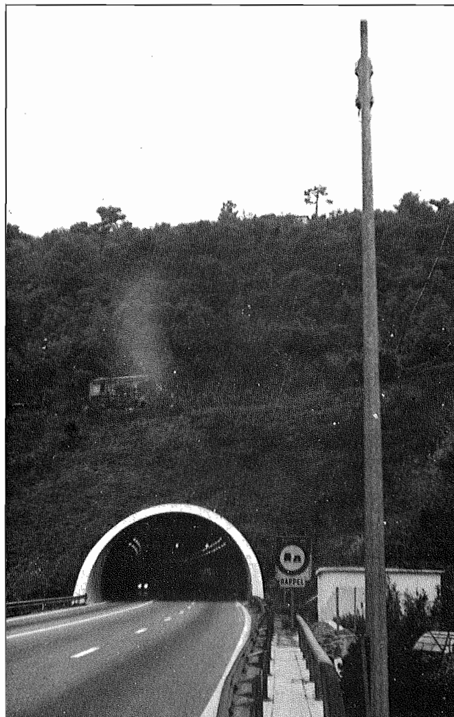
Fig. 100. — Tunnel de Pessicart. Cellules regardant l'entrée positionnées sur un mât.
