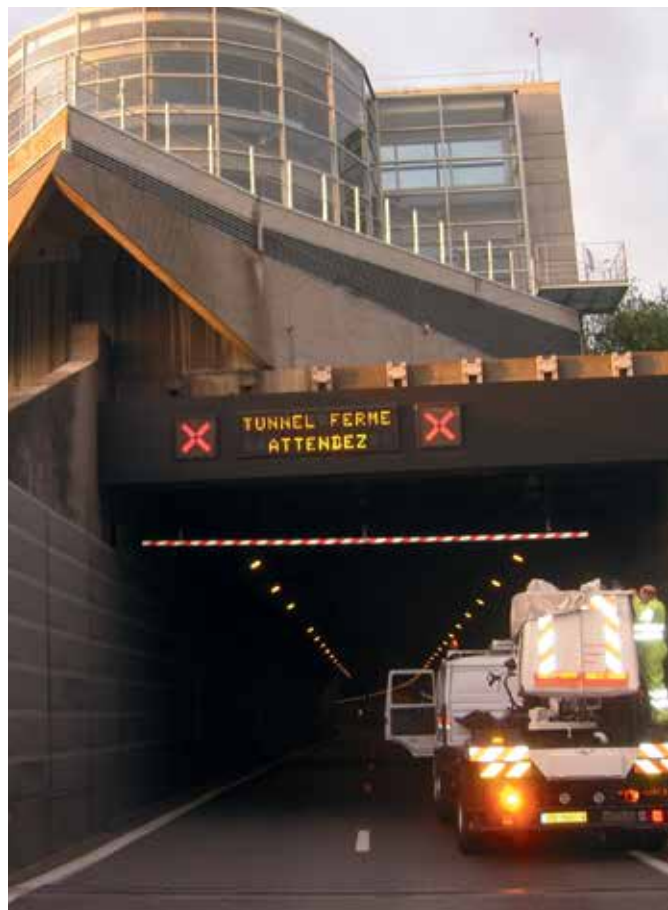
Figure 5 : usine de ventilation en tête de tunnel
