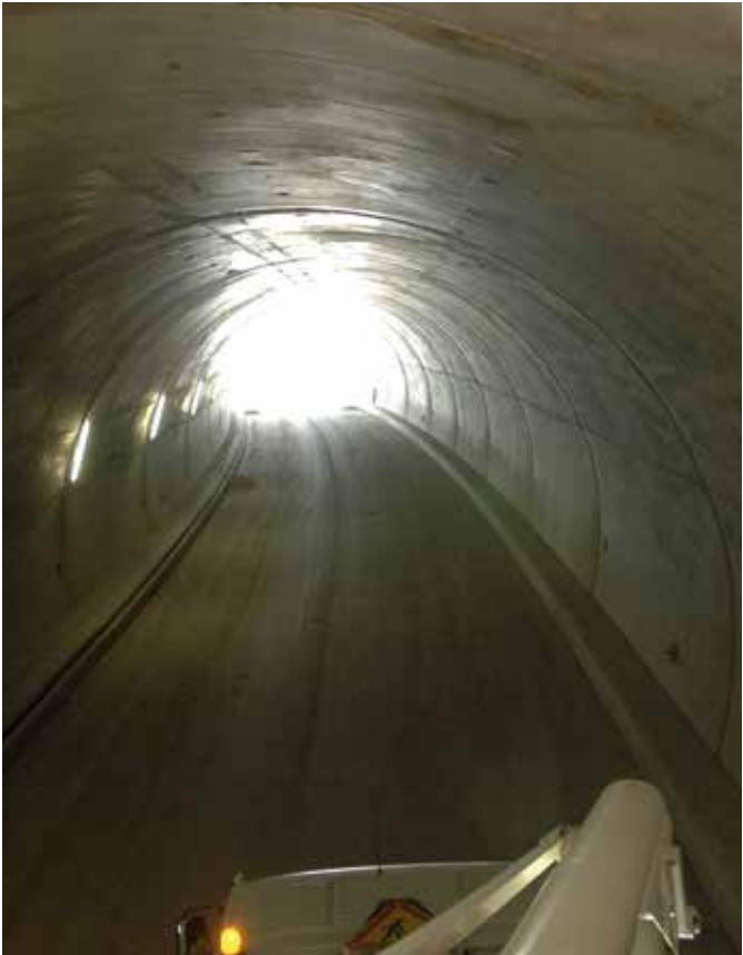
Figure 8 : revêtement en béton non armé
