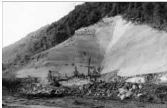
Exemple d'entrée en tunnel (tunnel de Foix)
