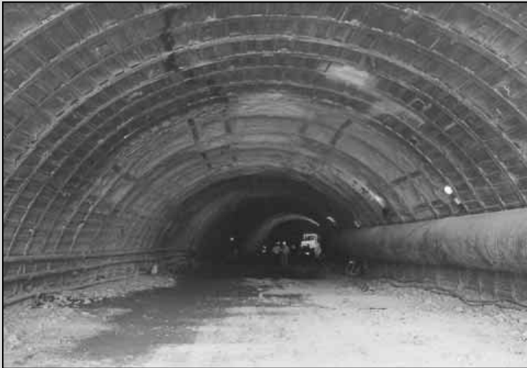
Profil de soutènement avec cintres lourds
