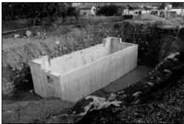
Bassin de stockage
