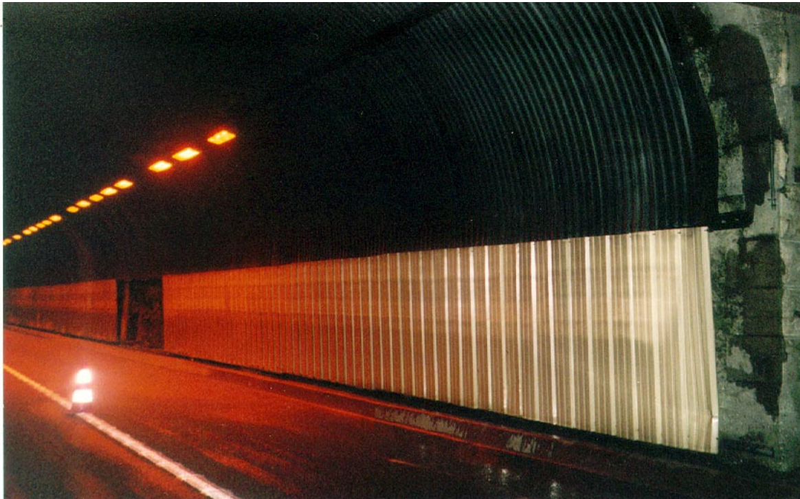
Photo 3 Tunnel du Chat tôle parapluie en voûte tôle d'acier galvanisé prélaquée mise sur les parois
