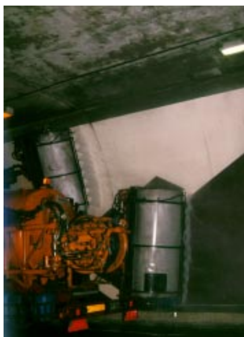
Photo 1 Tunnel du Puymorens Brossage des parois
