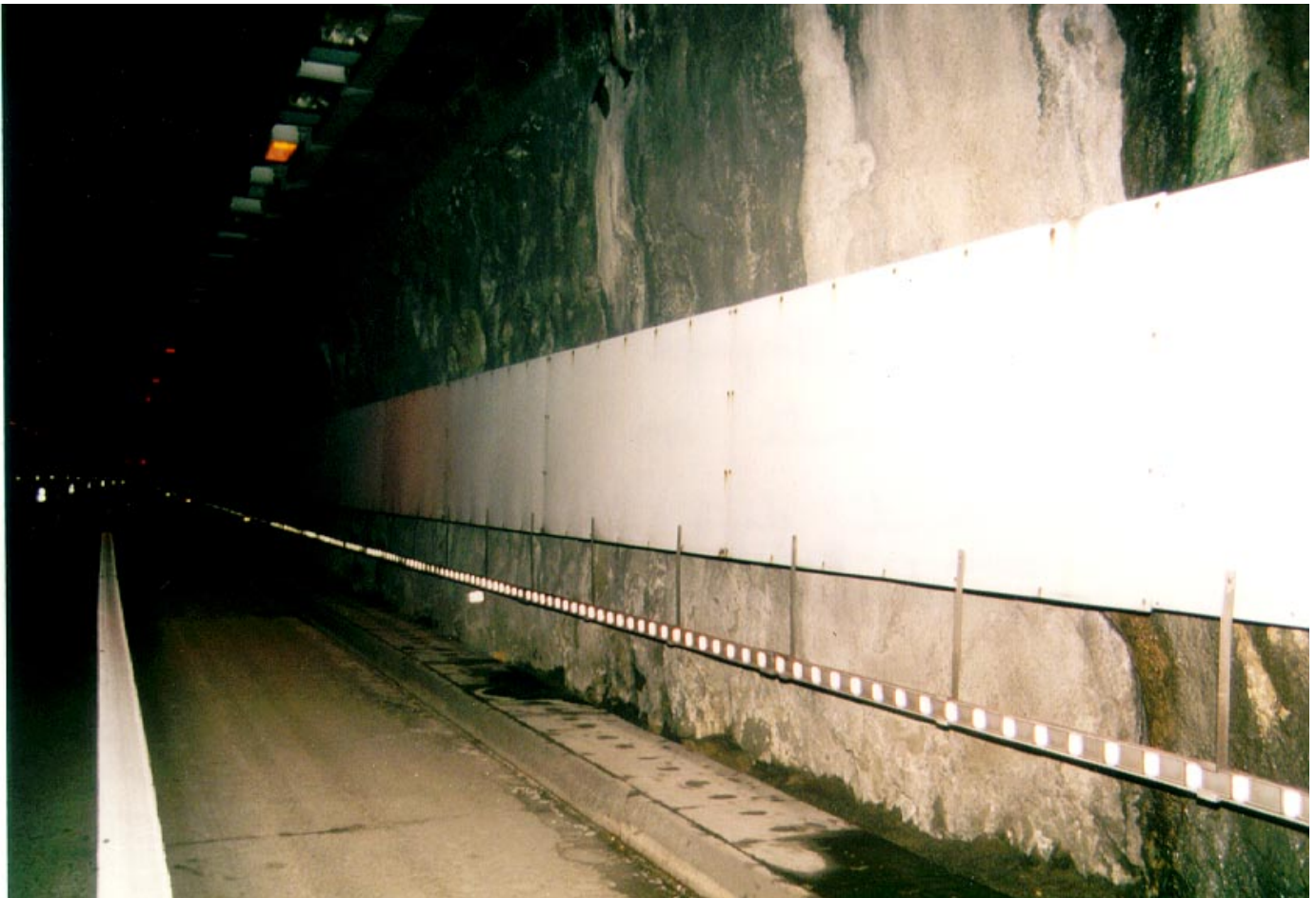
Photo 2 Tunnel de l'Epine nord Plaques de Glasal mises sur les parois de béton projeté à l'entrée du tunnel
