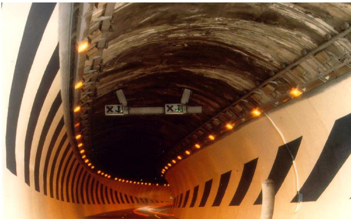
Photo 4 Tunnels du contournement de Nice Guidage optique sur les parois par peinture et animation colorée
