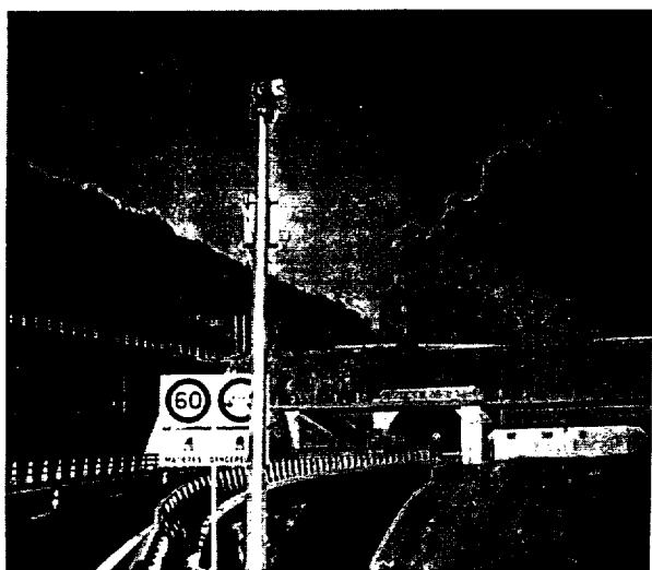
Capteur sur mât dans la zone d'approche d'un tunnel.
