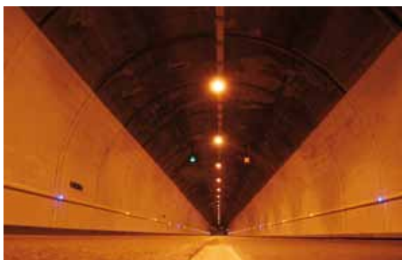
Tunnel du Rond-Point
