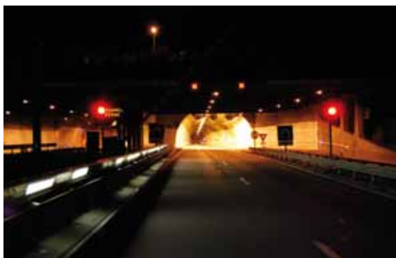
Tunnel du Rond-Point
