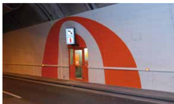
Tunnel du Rond-Point
