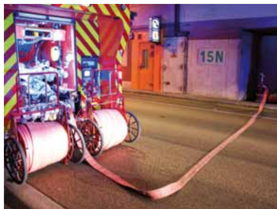
Tunnel de Toulon
