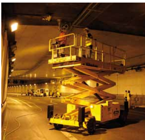
Tunnel de La Défense A14
