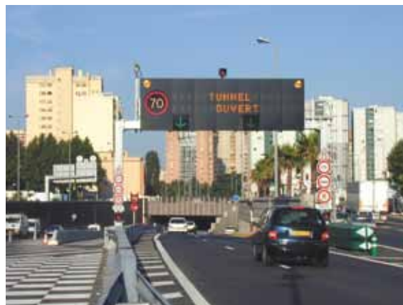
Tunnel de Toulon
