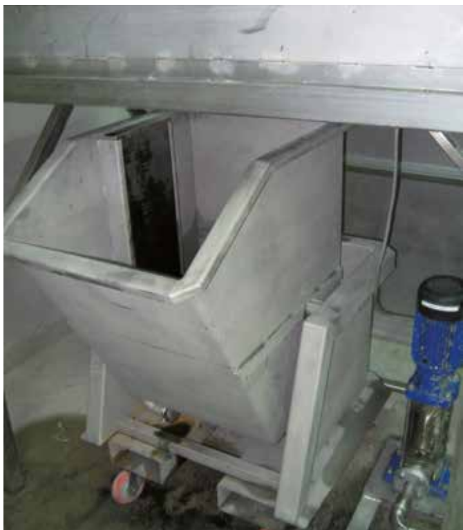
Illustration 38 : point de récupération des résidus de traitement à l'extrémité du système de traitement de l'eau de lavage des filtres (Filtrontec)
