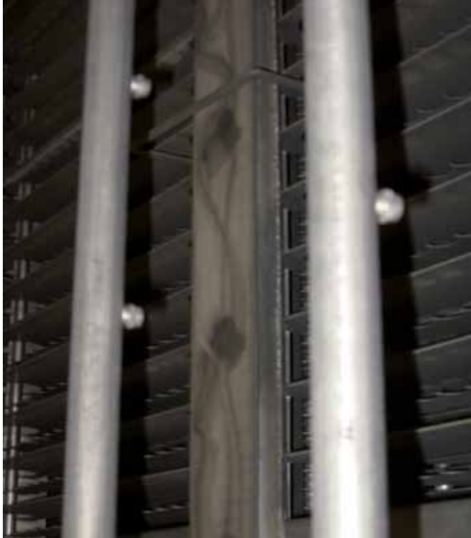
Illustration 25 : buses de lavage de l'ionisateur (CTA)
