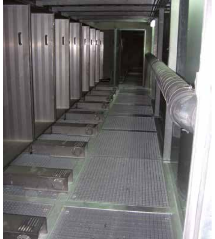
Illustration 23 : à gauche, armoires contenant les filtres électrostatiques, et à droite, système déNOx (l'air circule de la gauche vers la droite)
