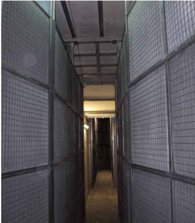
Illustration 29 : système DéNOx – l'air circule entre les panneaux visibles sur la photo, de l'arrière vers l'avant – la forme évasée a pour but d'augmenter la surface des panneaux (profil en W vu de dessus) et donc les surfaces de contact entre l'air et la charbon actif, pour augmenter l'efficacité du système
