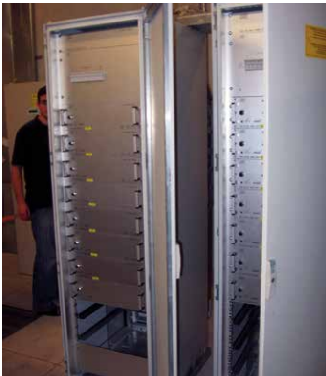
Illustration 34 : armoires contenant les unités élémentaires de transformation pour le courant d'ionisation (CTA)
