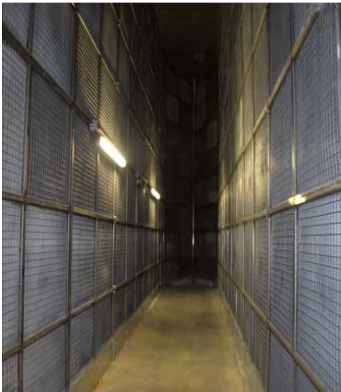
Illustration 30 : système DéNOx – l'air circule entre les panneaux visibles sur la photo, plusieurs mètres de longueur sont nécessaires pour que la surface de contact soit suffisante
