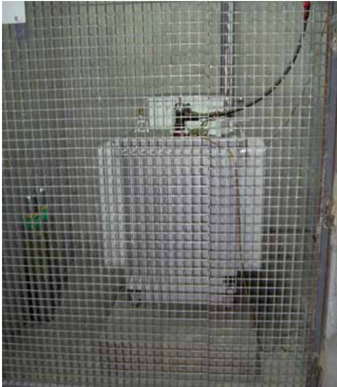
Illustration 33 : transformateur haute-tension pour le courant d'ionisation (Aigner)
