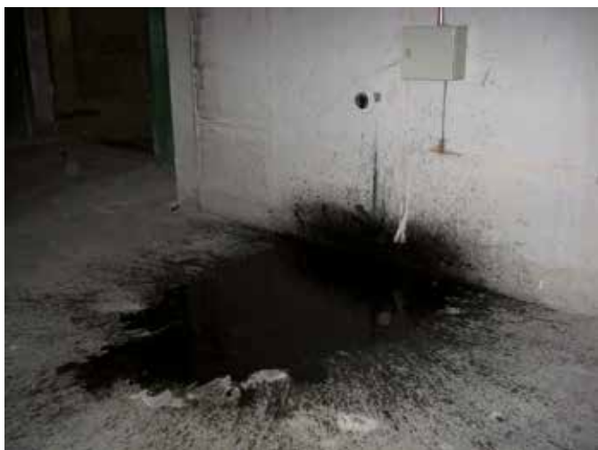
Illustration 39 : point de récupération des résidus de traitement à l'extrémité du système de traitement de l'eau de lavage des filtres (CTA)
