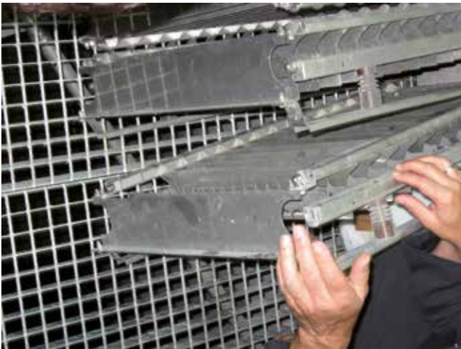
Illustration 22 : éléments du système d'ionisation
