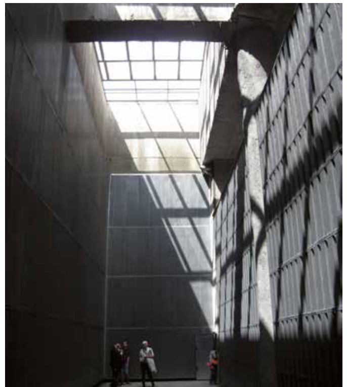
Illustration 32 : extrémité du système de traitement (l'air arrive depuis la droite, remplit le plénum puis s'échappe par l'ouverture en plafond) – sur la droite les baffles acoustiques montrent la taille de la section aéraulique nécessaire pour que les vitesses de passage dans le système ne soit pas trop élevées – en partie haute, à droite, dans l'ombre, ouverture qui constitue l'extrémité de la gaine parallèle au circuit de traitement permettant de court-circuiter le système de traitement en cas d'incendie
