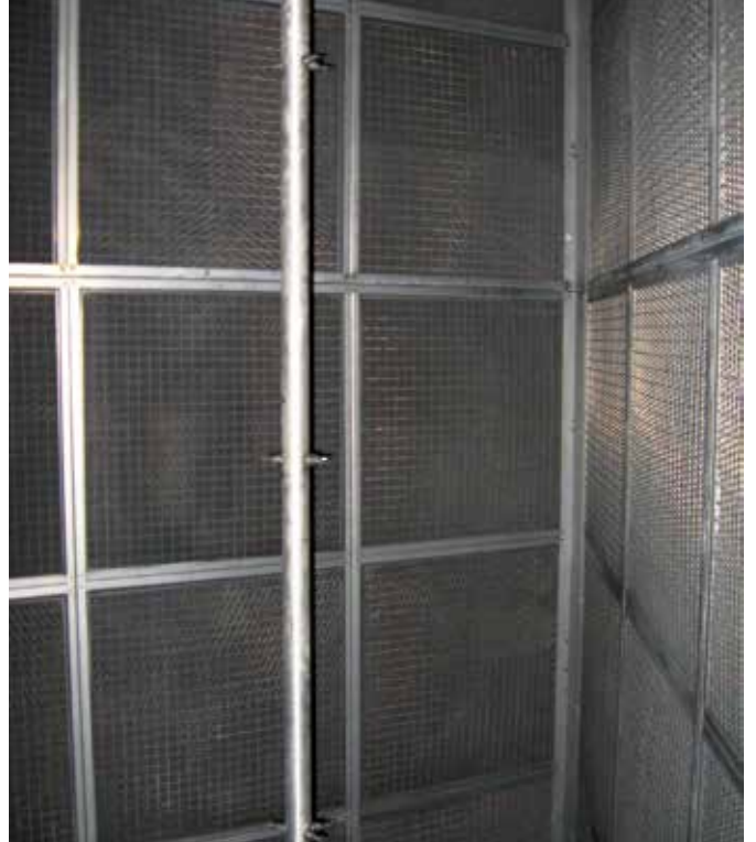
Illustration 27 : filtres électrostatiques et leurs buses de lavage (CTA)
