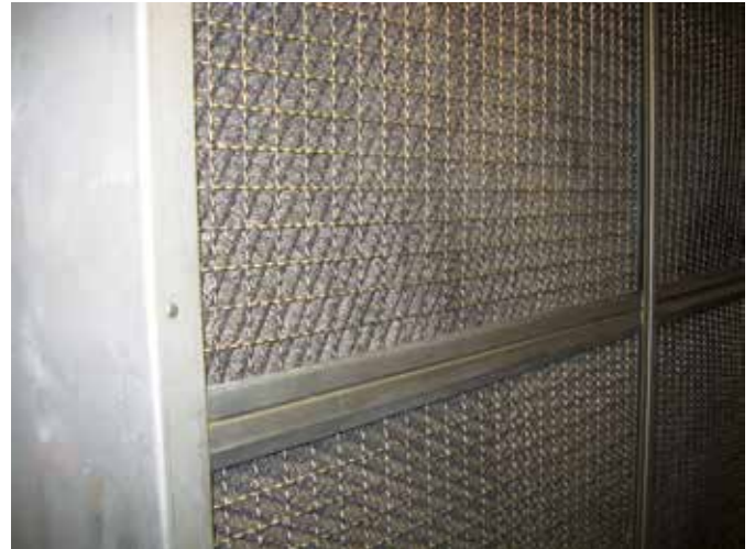
Illustration 31 : système DéNOx – gros plan sur les panneaux à l'intérieur desquels se trouvent les boules de charbon actif
