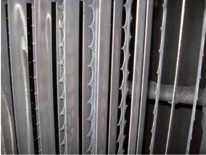
Illustration 21 : ionisateur – la différence de potentiel est établie entre les pointes visibles sur la photo, l'air est chargé électriquement à son passage entre les lames
