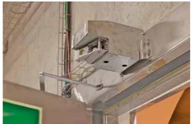
Figure 5 : système d'assistance à l'ouverture par vérin électrique (tunnel de Violay, autoroute A89). À gauche : porte fermée, à droite : porte ouverte
