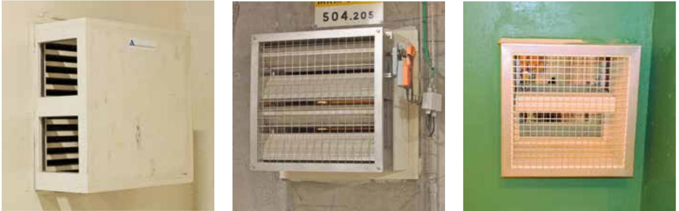
Figure 4 : clapets de décompression coupe-feu N2. À gauche : côté tunnel, la protection contre le rayonnement thermique est assurée par des plaques de matériau inerte. Au centre : côté issue, le registre ne s'ouvre que partiellement pour doser la surpression. À droite : clapet « tout en un » avec volet mobile en matériau inerte (position ouverte, vue depuis le tunnel)
