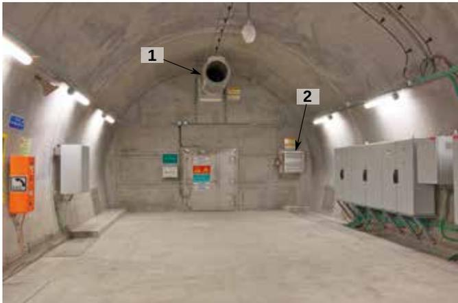
Figure 3 : vue générale de l'intérieur d'un rameau intertube (tunnel de Violay, autoroute A89). On distingue notamment un ventilateur et son silencieux (1) et un clapet de décompression (2)
