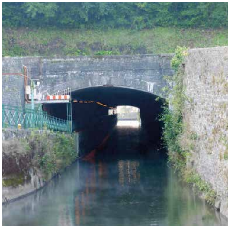
Tête Nord du tunnel-canal de Revin
