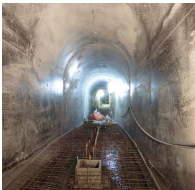
Rameau de Ponserand (73), ferrailage du radier
