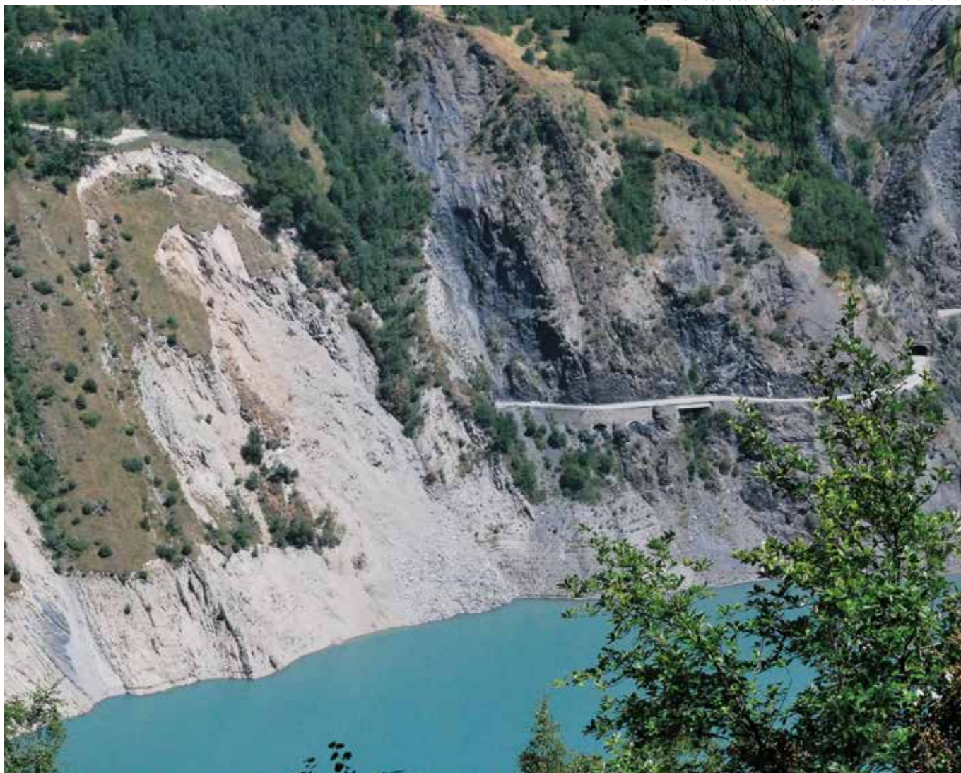
Glissement de versant au droit du tunnel du Grand Chambon
