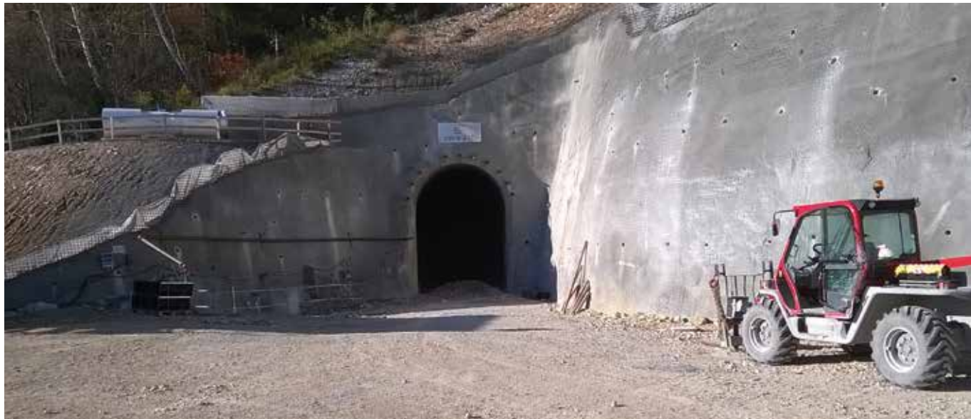
Galerie de secours du tunnel du Chat
