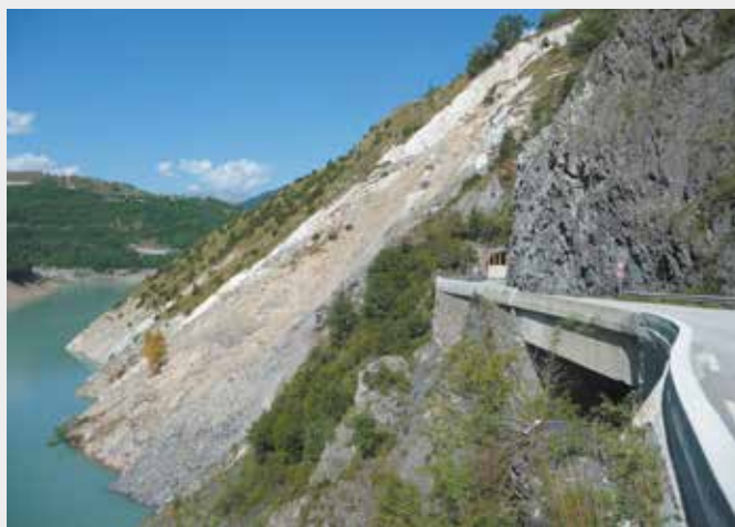
Tunnel du Grand-Chambon
