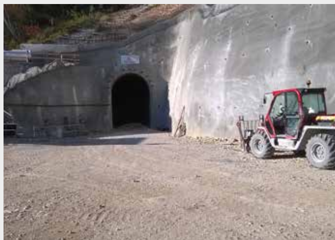
Creusement de la galerie de sécurité du tunnel du Chat
