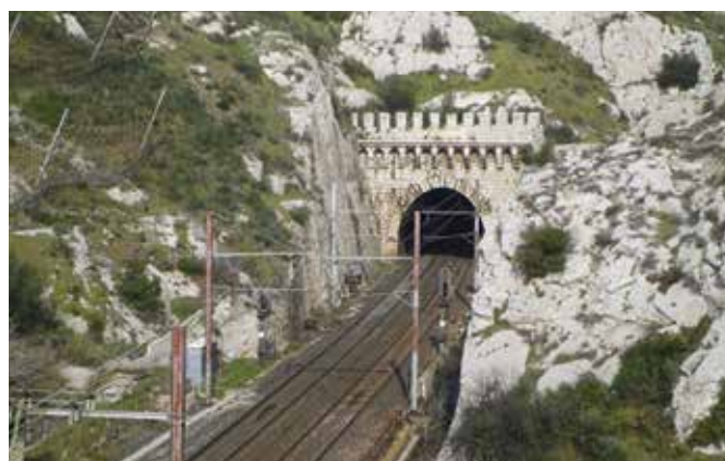
Tunnel de la Nerthe, tête sud
