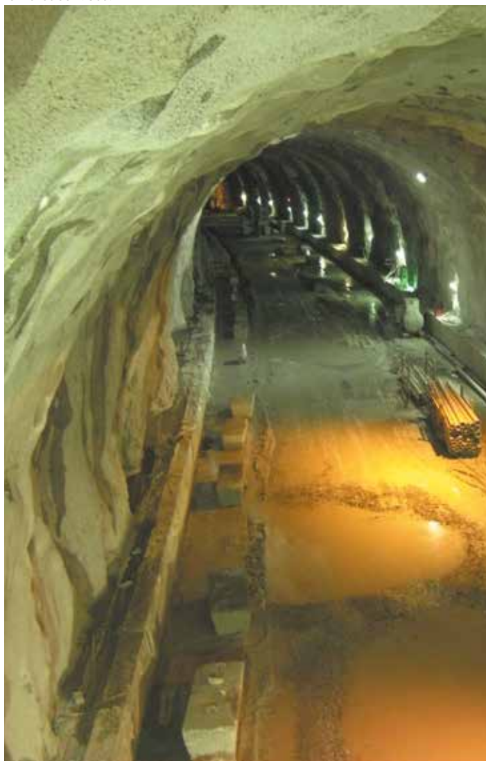
Tunnel de Saint-Béat
