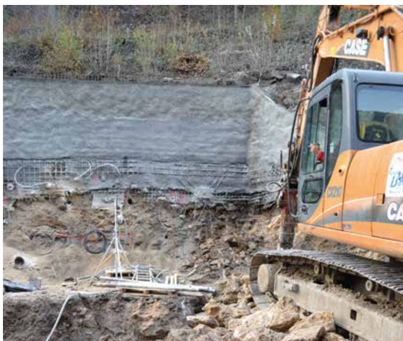
Travaux extérieurs en tête amont de la future galerie du Siaix (73)
