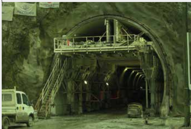
Tunnel de Saint-Béat
