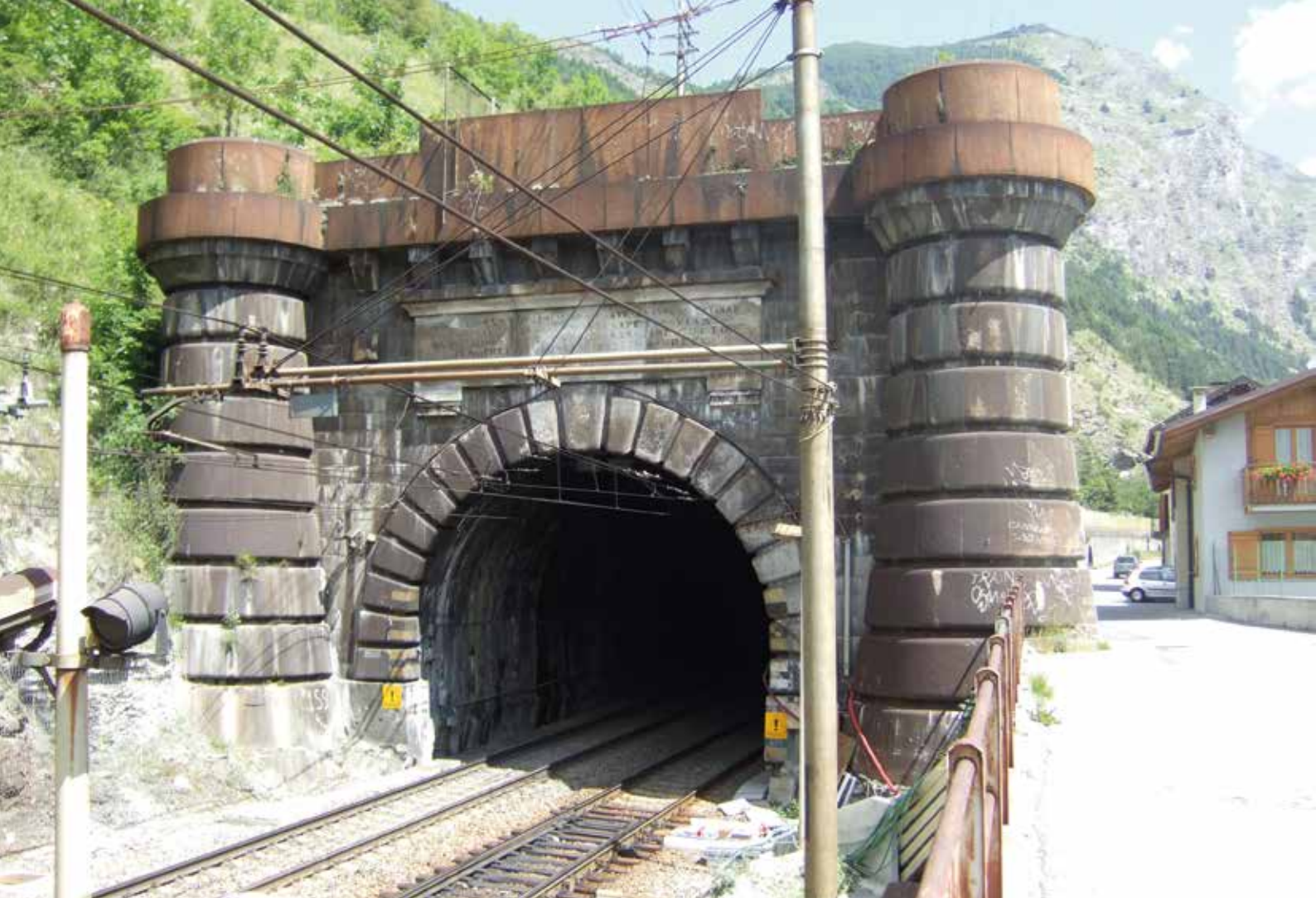
Tunnel ferroviaire du Fréjus, côté Italie (photo K. Weise)
