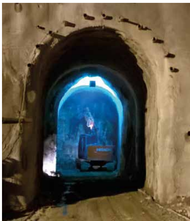
Creusement de la galerie de secours du tunnel du Chat
