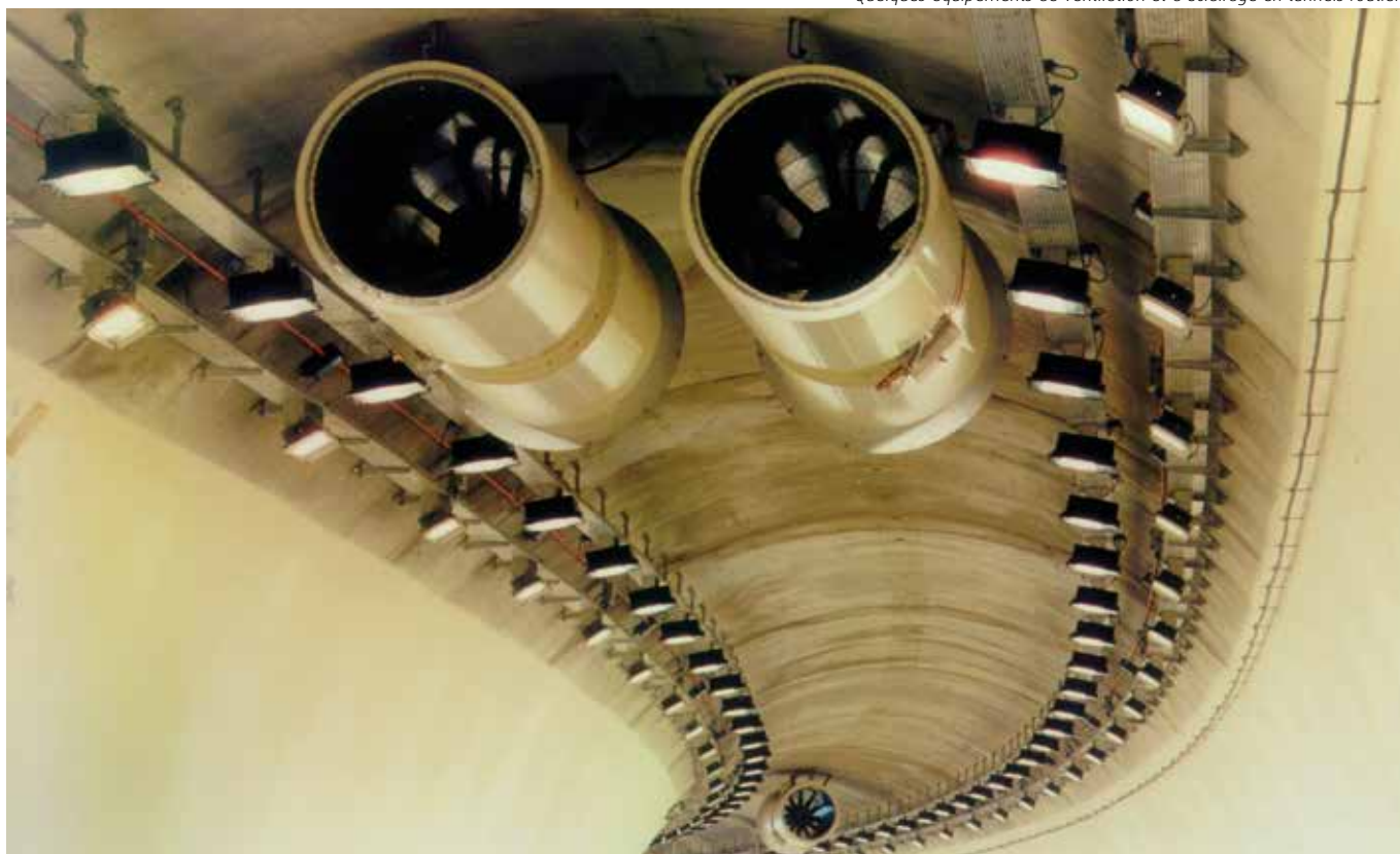
Quelques équipements de ventilation et d'éclairage en tunnels routiers
