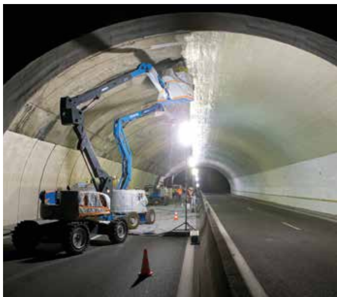
L'étanchéité par SELA appliquée sur la moitié du tunnel
