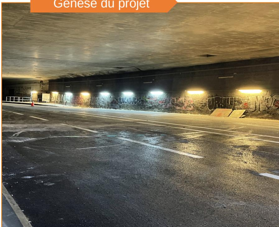
L'importance prise par la LED dans le secteur des tunnels et le manque de retour d'expérience sur ses performances dans ce milieu ont amené la DiRIF à proposer de mettre à disposition le tube non exploité de la tranchée couverte d'Antony (A86) à des fins expérimentales.
