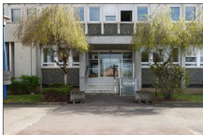
Entrée du bâtiment 1
