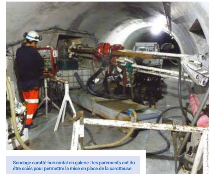
Sondage carotté horizontal en galerie : les parements ont dû être sciés pour permettre la mise en place de la carotteuse
