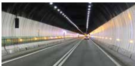
Essais d'éclairage LED au tunnel du Mont-Blanc
