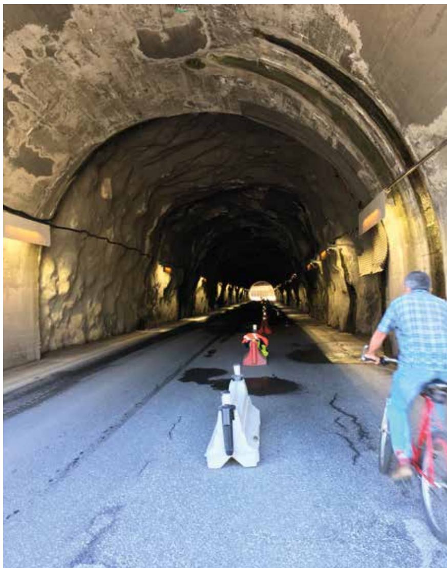
Tunnel de Villaret du Nial
