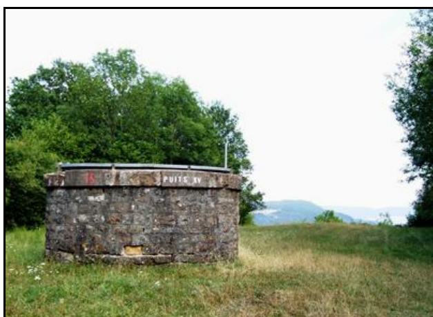
L'ouverture du puits n° 15 de 200 m de profondeur
