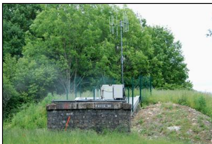
Le débouché du puits XV aujourd'hui, équipé d'équipements de télétransmission radio pour la sécurité Noter les vapeurs de condensation qui s'échappent du puits
