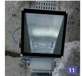
Photo 10 : luminaire LED en éclairage de section courante dans le tunnel Diano Calderina sens France Italie
