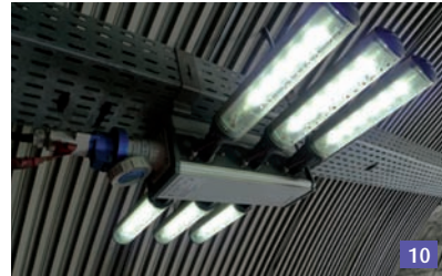
Photo 10 : luminaire LED en éclairage de section courante dans le tunnel Diano Calderina sens France Italie
