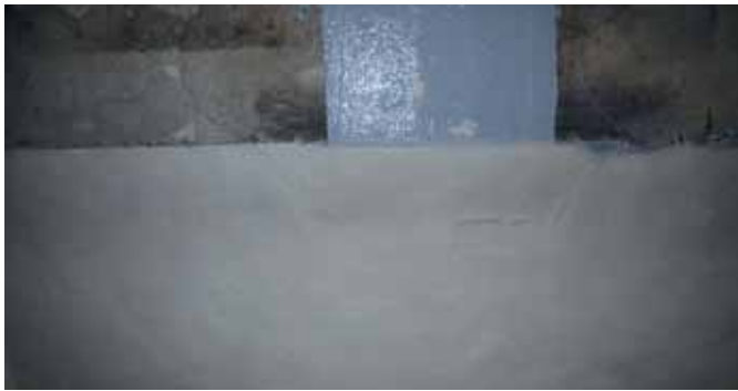
Résine projetée en piédroit
