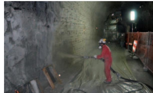
Tunnel des Echelles, projection béton de revêtement, expérimentation ECOMINT
