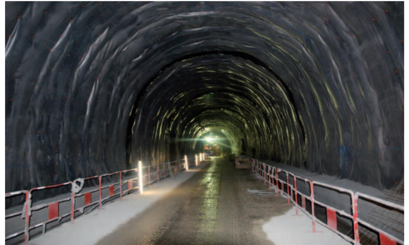
Tunnel de Talant : procédé d'étanchéité à base de géomembranes synthétiques
