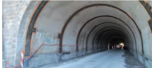
Tunnel du Col de Menée (26) : étanchement des joints de bétonnage et de la base des piédroits
