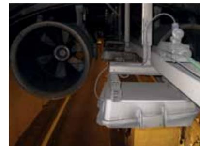
Inspection des accélérateurs et appareil d'éclairage en voûte. Tunnel du Rond-Point, Saint-Étienne
