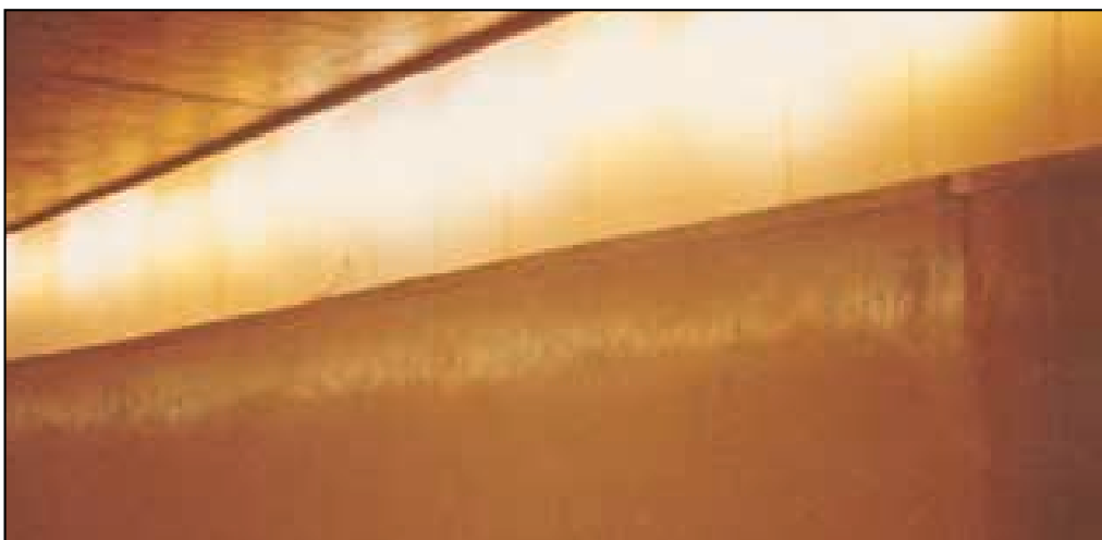
▲ Photo n° 16 - Galerie latérale d'éclairage dans la tranchée couverte de Champigny (Autoroute A4 - Val de Marne)
