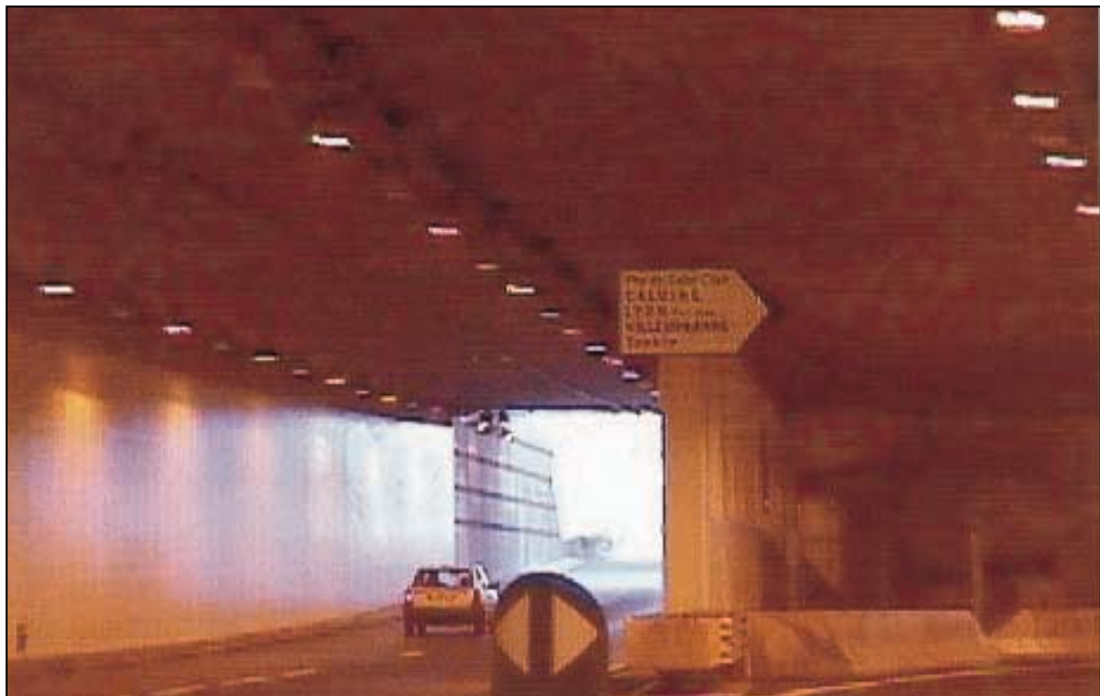
▲ Photo n° 7 - Bretelle de sortie dans le tunnel de Rochecardon (Boulevard Périphérique Nord de Lyon)
