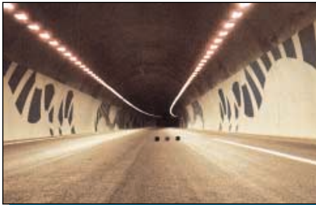
▲ Photo n° 5 - Piédroits clairs avec éclairage à contre-flux dans le tunnel des Treize Vents (Autoroute A 55)
