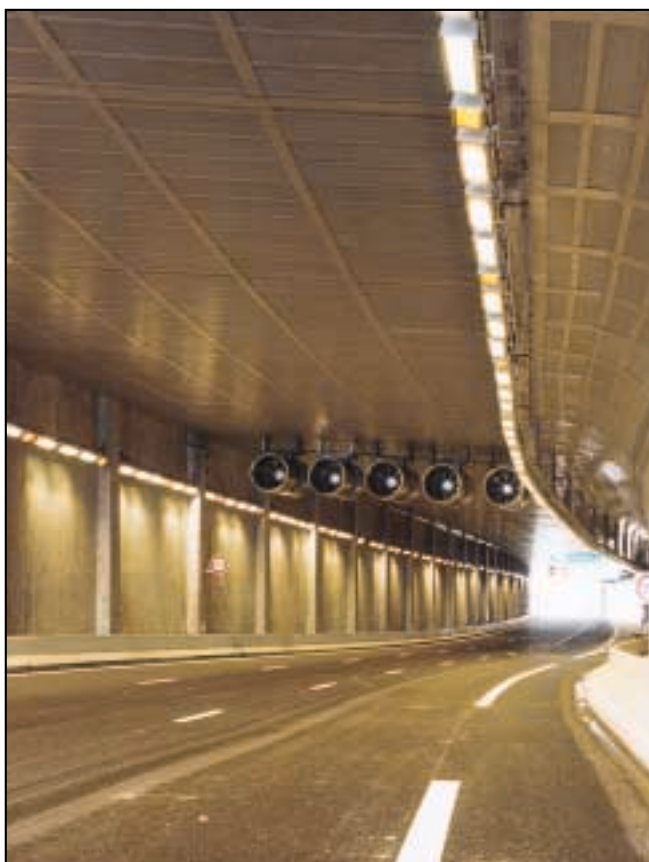
▲ Photo n° 10 - Tunnel de Bobigny-Drancy sur A86 en Seine Saint-Denis (zone de sortie)
