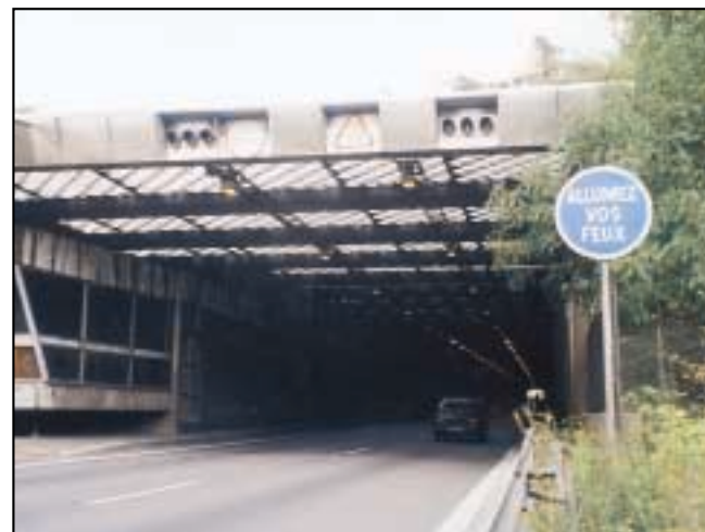
▲ Photo n°26 - Paralumes à l'extrémité du tunnel du Rond-Point (Saint-Etienne)
