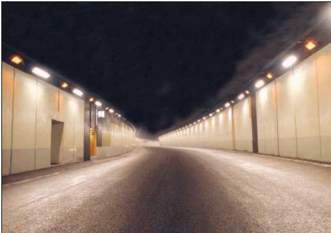
▲ Photo n° 8 - Tunnel de la Grand-Mare sur la RN 28 à Rouen (section courante)
