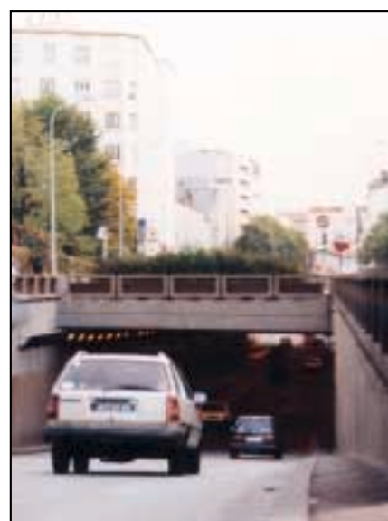
▲ Photo n° 11 - Trémie des Brotteaux à Lyon (la condition de "sortie visible" n'est pas remplie)
