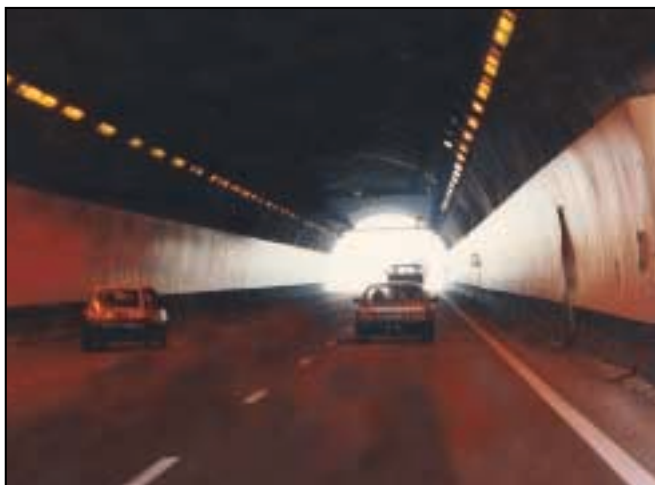
▲ Photo n°19 - Deux files d'appareils en voûte dans le tunnel du Rosti (Autoroute A 8 - Alpes Maritimes)
