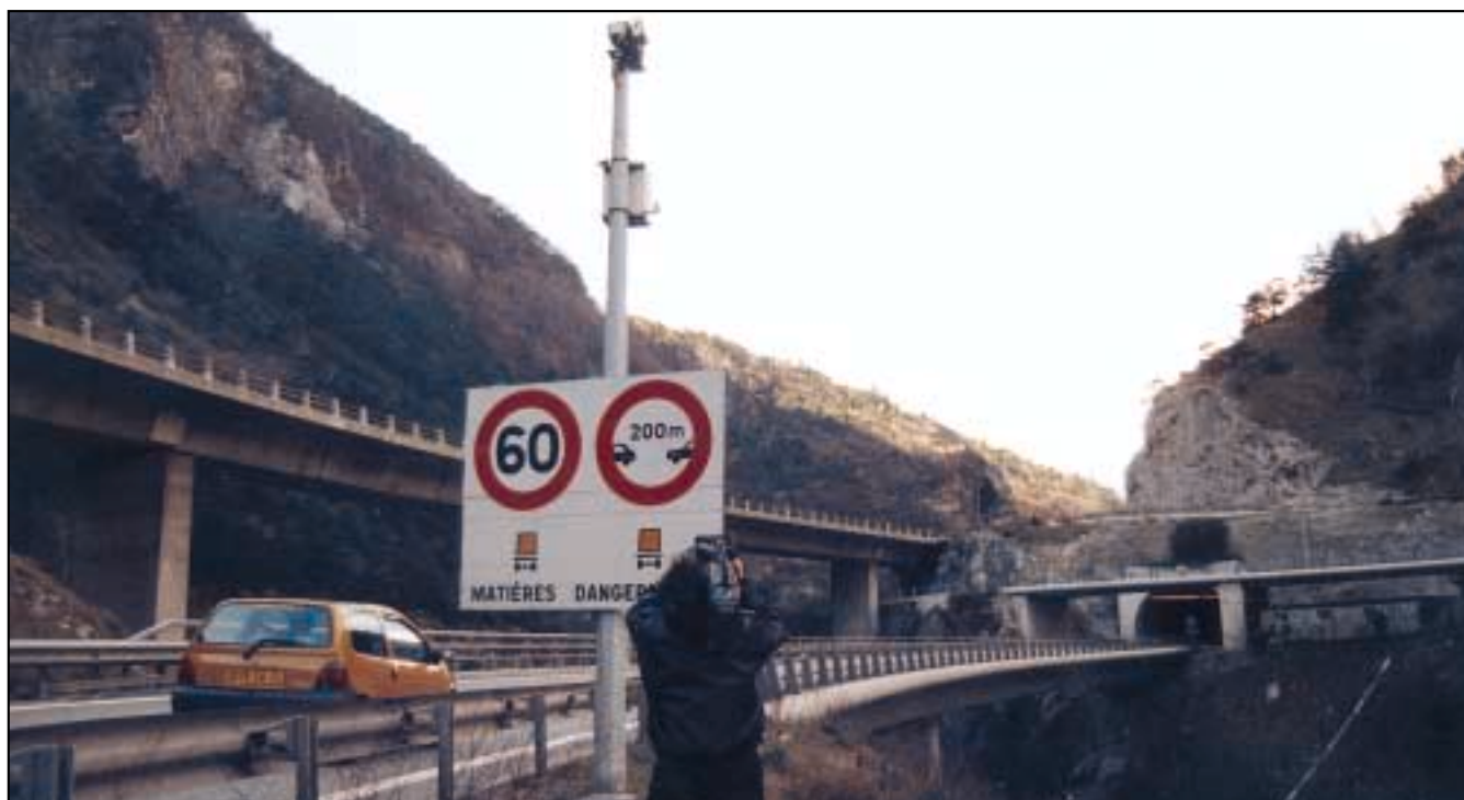
▲ Photo n°25 - Dispositif de commande au tunnel de Ponsérand (RN 90 - Savoie)
