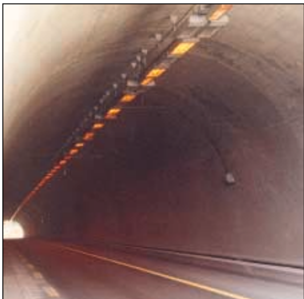
▲ Photo n°20 - File unique d'appareils dans le tunnel de Noailles (RN 20 - Corrèze)
