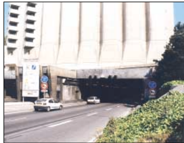
▲ Photo n° 9 - Entrée du tunnel de Fourvière (Lyon)
