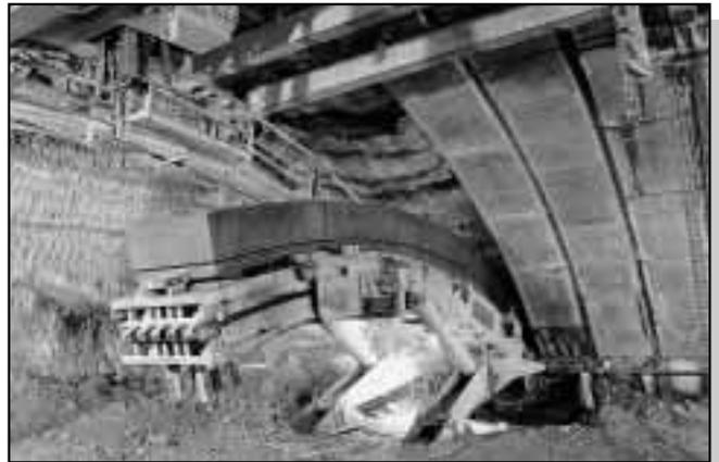
▲ Fig. 3.4- Exemple de pose d'une voûte active (Station Chatelet de Meteor)
