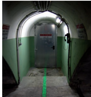
La ligne verte au sol présente un guidage efficace et sans ambiguïté vers l'extérieur. Le bas du mur peint en vert renforce la capacité de guidage.
