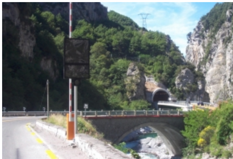
Tunnel de Saorge – DDE 06
