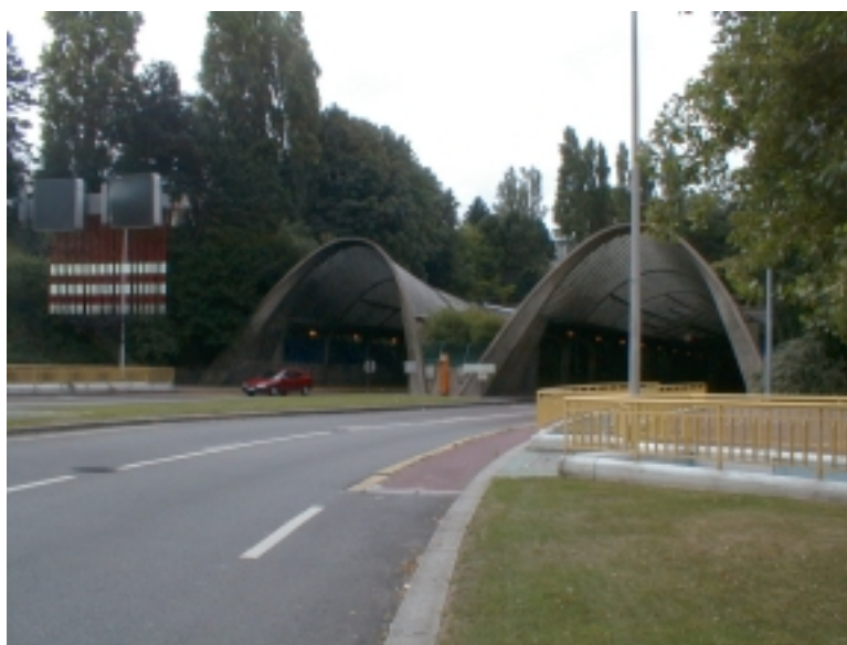
Un tunnel urbain : Tunnel Jenner au Havre (Tête nord)
