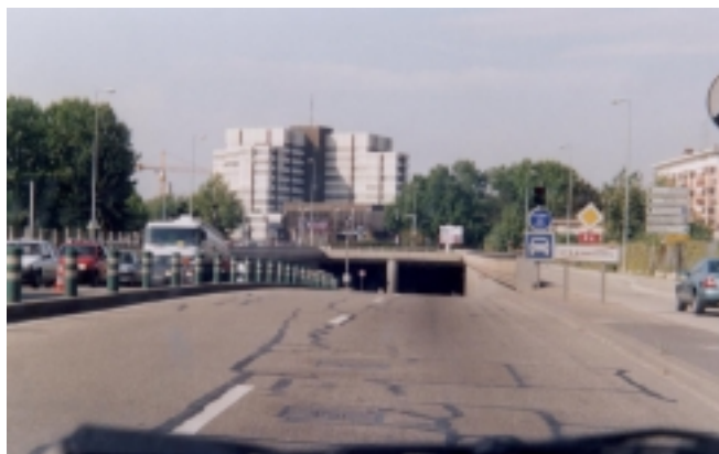
Photo de la tête est du tunnel de l'Étoile à Strasbourg.
