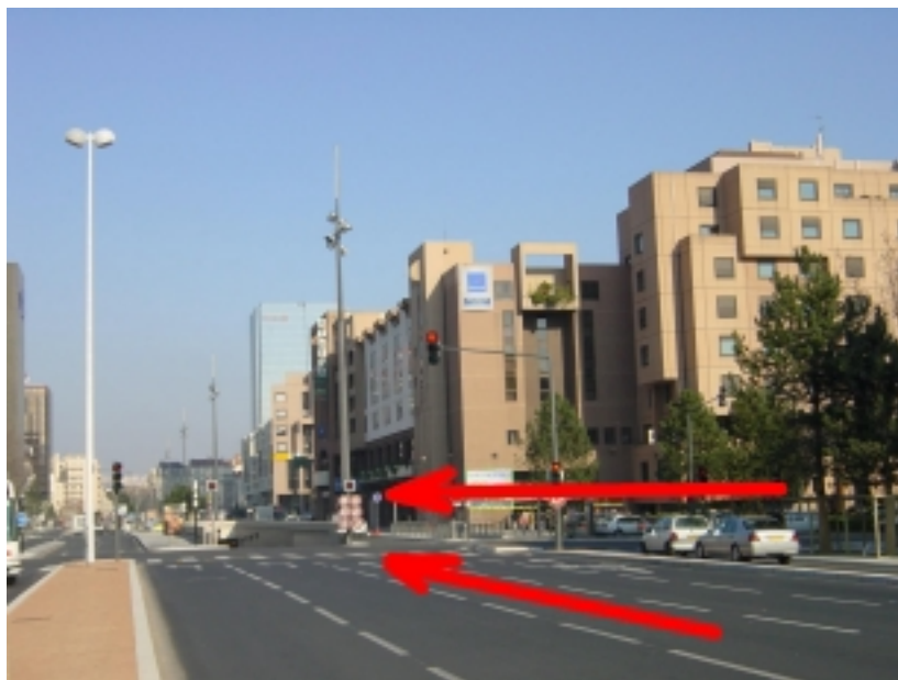
Tranchée couverte Vivier Merle à Lyon, les accès ne sont pas tous dans l'axe du tunnel.
