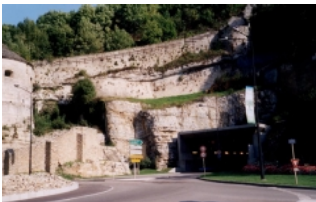
Photo de la Tête Tarragnoz du tunnel de la Citadelle à Besançon
