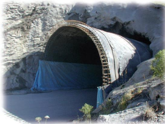
Coque formant « fausse tête » en cours de travaux au tunnel des Aravis.
