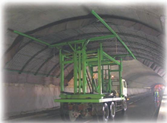
Transport d'un anneau d'ossature au tunnel de Sisteron.
