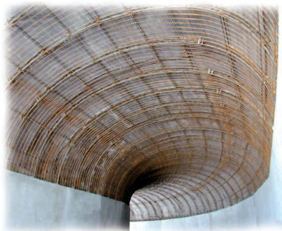
Ossature métallique posée sur les soubassements formant piédroits au tunnel des Aravis.
