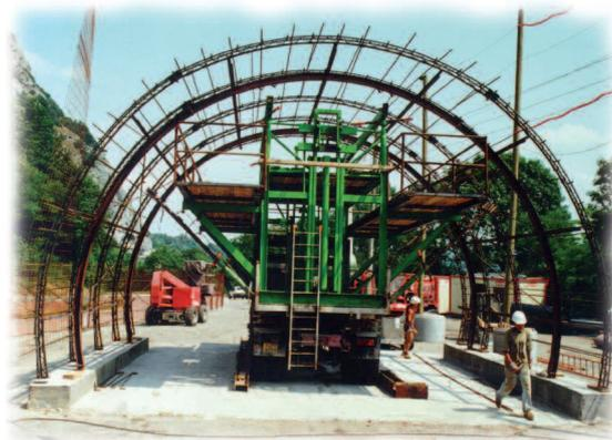
Aire de préfabrication de l'ossature au tunnel de Fort l'Écluse.
