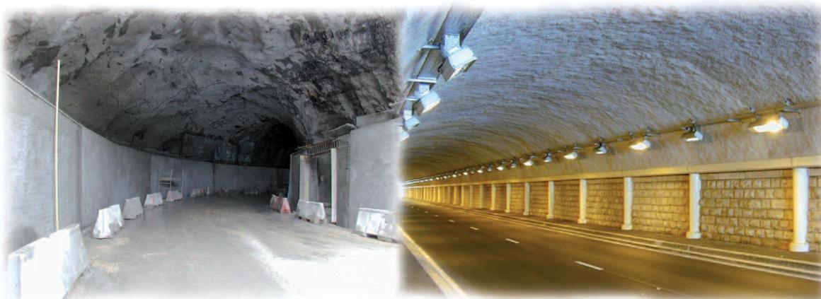
*Soubassements en béton projeté taloché au tunnel des Aravis.*
