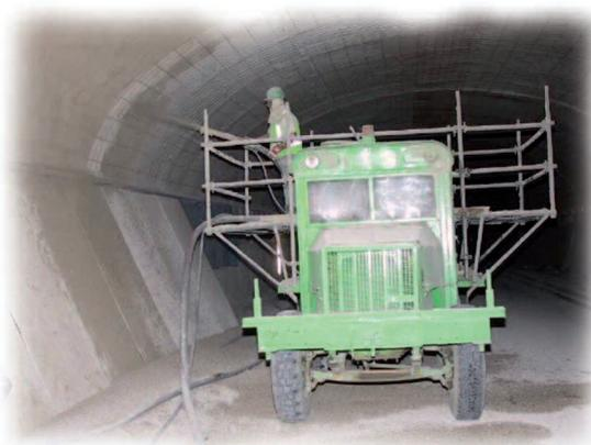
Projection du béton de la coque du tunnel de Sisteron avec protection des piédroits conservés.
