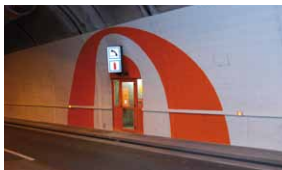
Tunnel du Rond-Point
