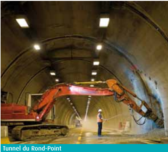
Tunnel du Rond-Point
