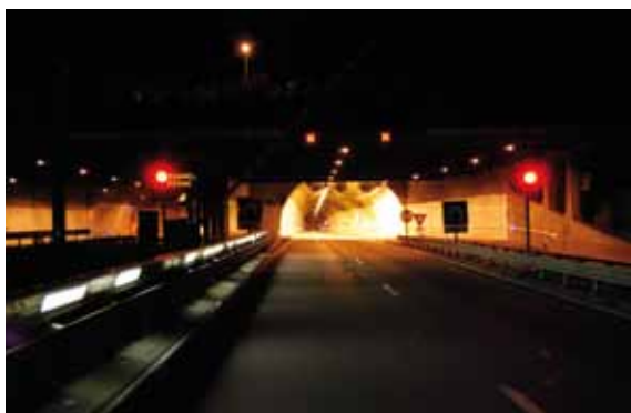
Tunnel du Rond-Point
