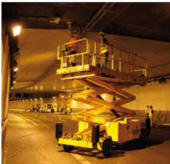
Tunnel de La Défense A14
