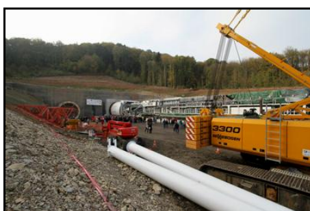
Ci-dessus et ci-dessous, le tunnelier et son long train suiveur
