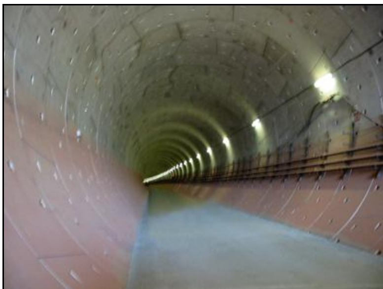
La galerie terminée et prête à recevoir les aménagements ferroviaires
