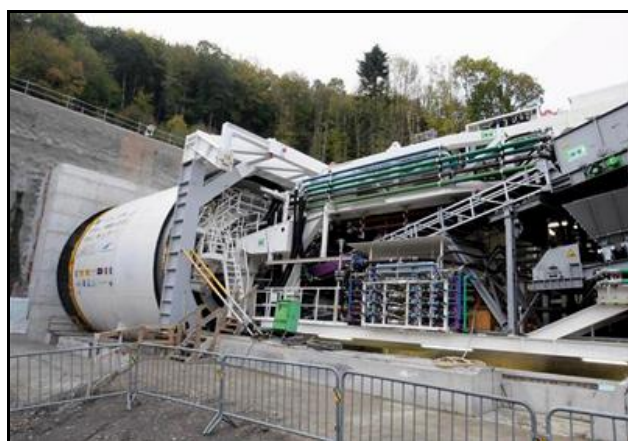
Ci-dessus et ci-dessous, le tunnelier et son long train suiveur
