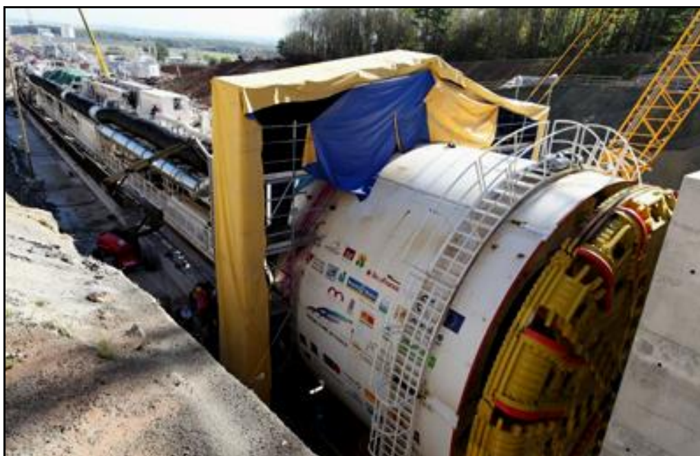
Le tunnelier prêt à l'emploi pour creuser le tube Nord La tête de coupe jaune est ici à droite
