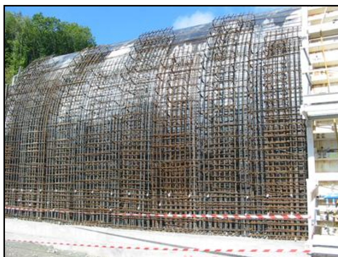
Ferrailage des faux tunnels qui constitueront les portails d'entrée et de sortie
