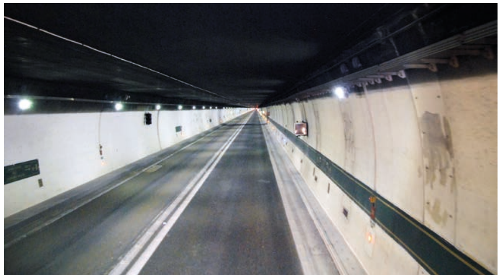
Tunnel routier du Fréjus – visite de contrôle extérieur de l'inspection détaillée de 2019
