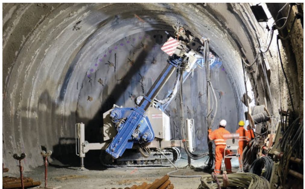
Creusement du prolongement de la ligne 11 du métro parisien (source RATP)
