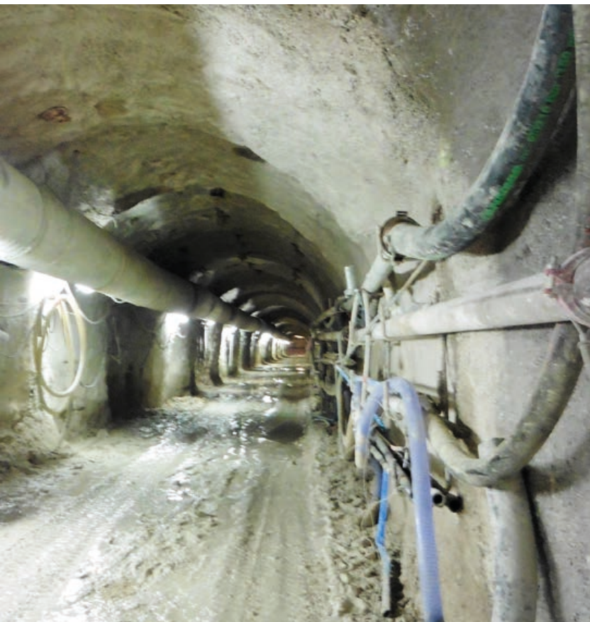
Galerie en cours de creusement
