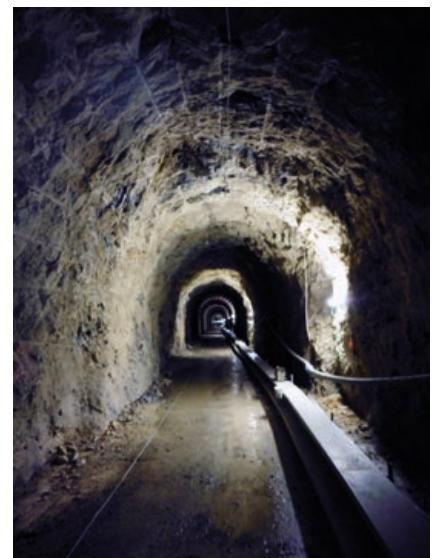
Zone non revêtue ; en bas à droite, réseau fibre et exploitation
