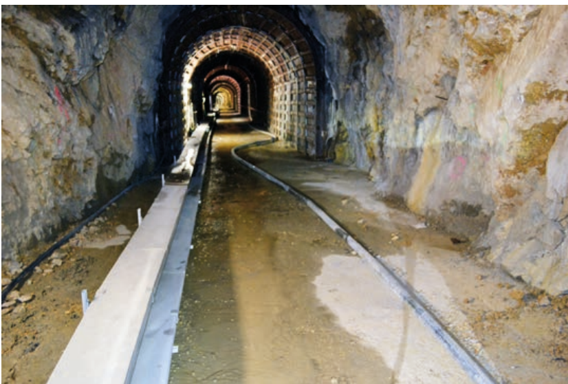
Zone non revêtue et, au fond, zone chemisée (travaux 2003)
