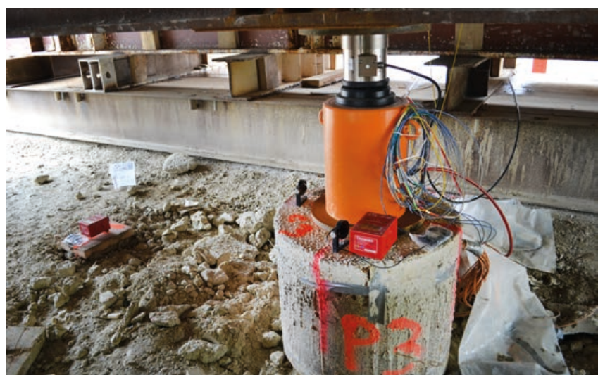
Figure 3 : Vue de la tête du pieu P3 et d'une partie de l'instrumentation (accéléromètres, cibles topographiques, peson...)
