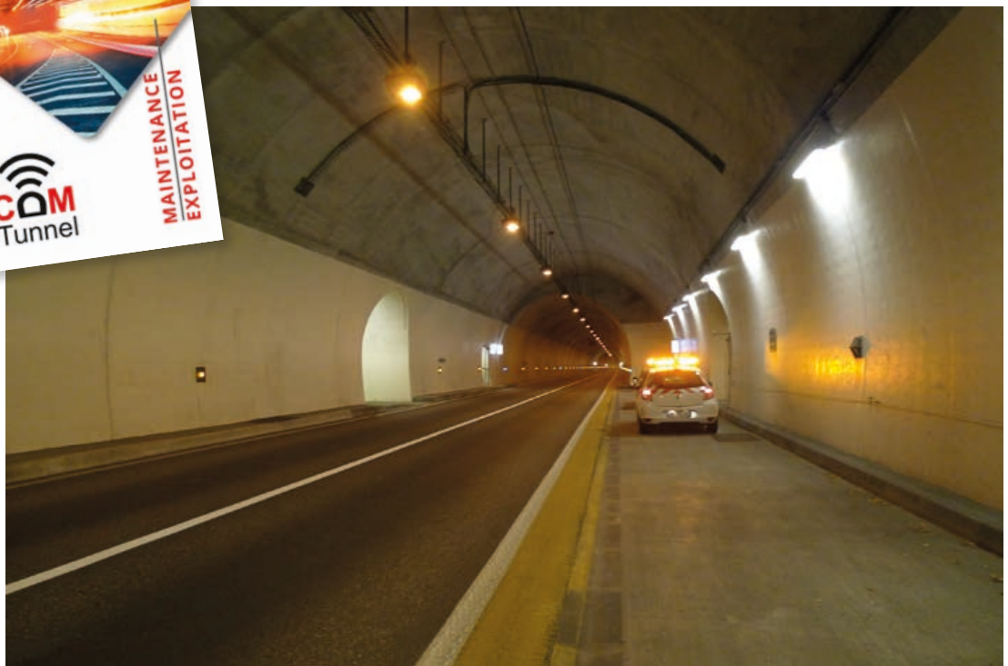
Tunnel des Grands Goulets
