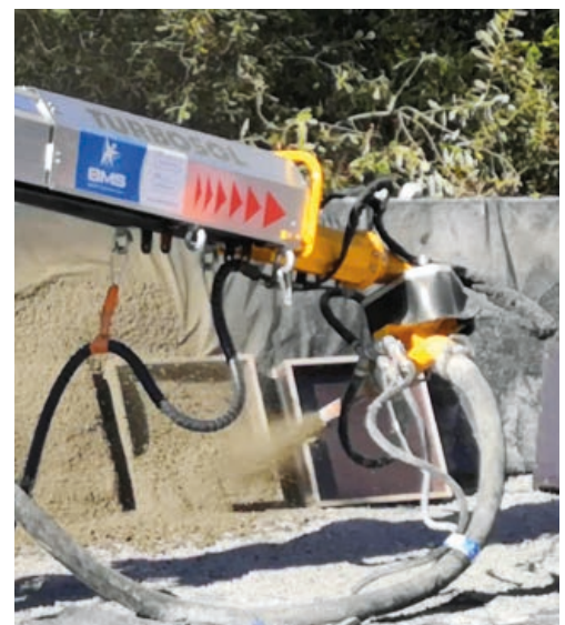
Les projections ont été réalisées avec un bras manipulateur TurboSol TSR7
