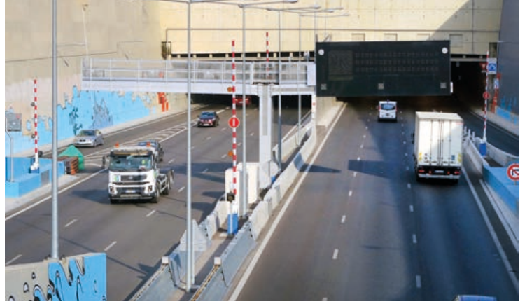
Vue tranchée ouverte
