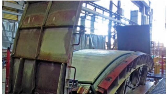
Démoulage d'un voussoir du lot 2 de la ligne 16 à l'usine Alliance à Limoges Fourche
