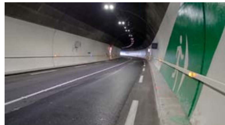
Tunnel de Baza, Aubenas
