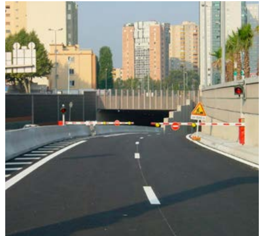
Dispositif de fermeture à l'entrée du tunnel de Toulon
