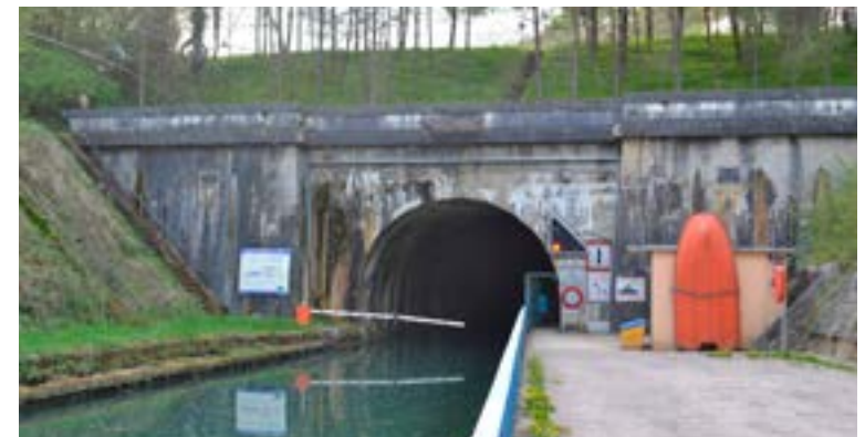
Tête du tunnel côté Mauvages
