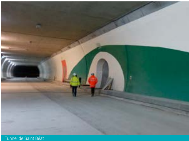
Tunnel de Saint Béat
