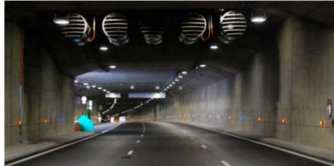
L2 Est int rieur de Tranch e Couverte avant mise en service
