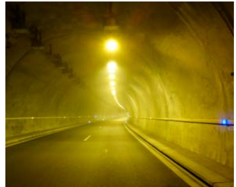
Tunnel de Fontain, optimisation des niveaux d'éclairage en fonction de la luminosité extérieure
