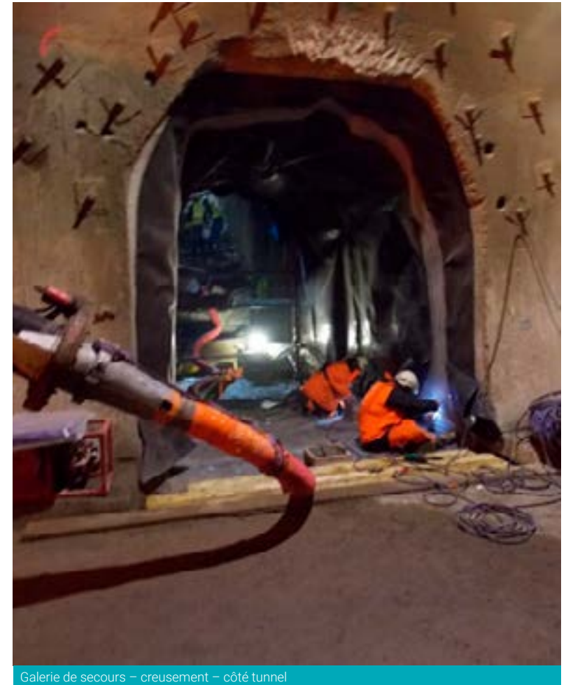
Galerie de secours – creusement – côté tunnel
