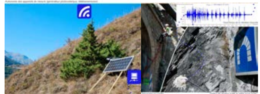
Autonomie des appareils de mesure (générateur photovoltaïque, télétransmission)
