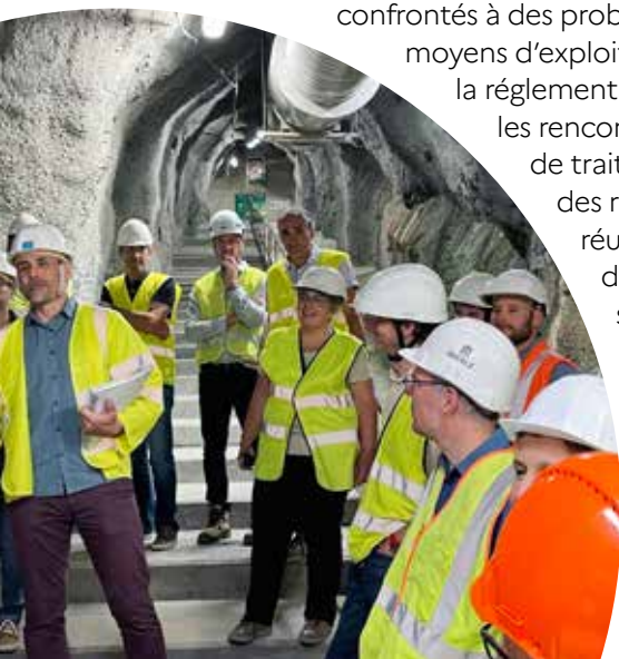
Comité Tunnels dans la Drôme : visite du tunnel des Grands Goulets
