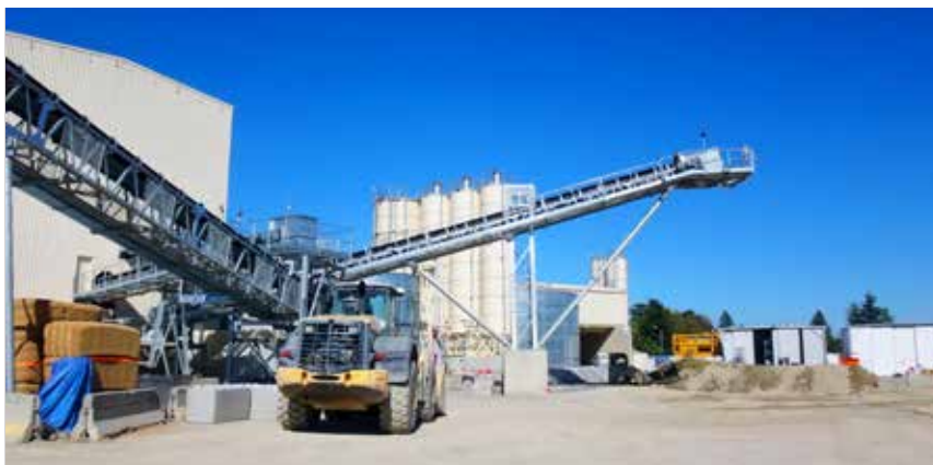
Installation de chantier du prolongement du métro B de Lyon à Hôpitaux Lyon Sud (source CETU)
