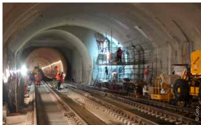
EOLE - Vue d'une des chambres de l'entonnement Ouest HSL
