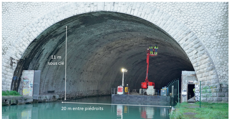
Nacelle installée sur un ponton flottant dans le tunnel du Rove
