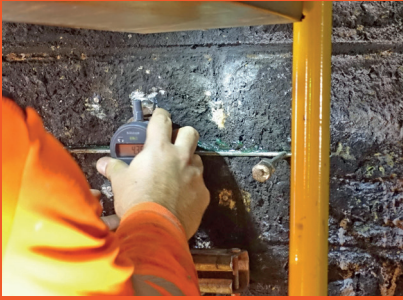
Mesures de contraintes au vérin plat
