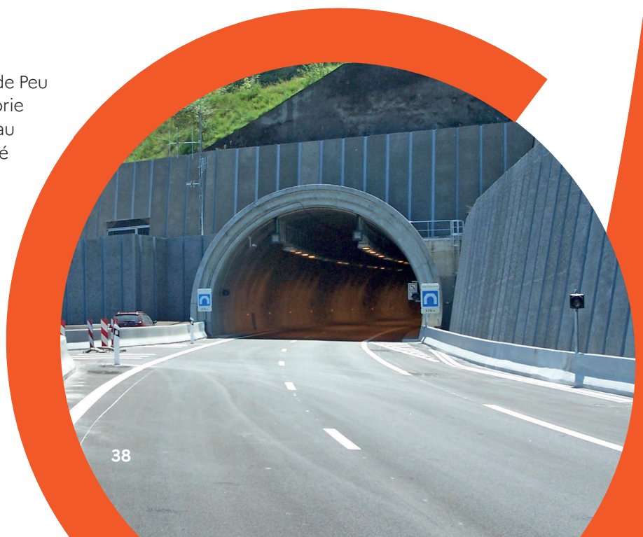
Le tunnel du Bois de Peu (Doubs)
