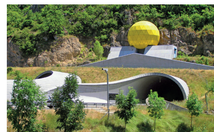
Tunnel du Pas de l'Escalette
