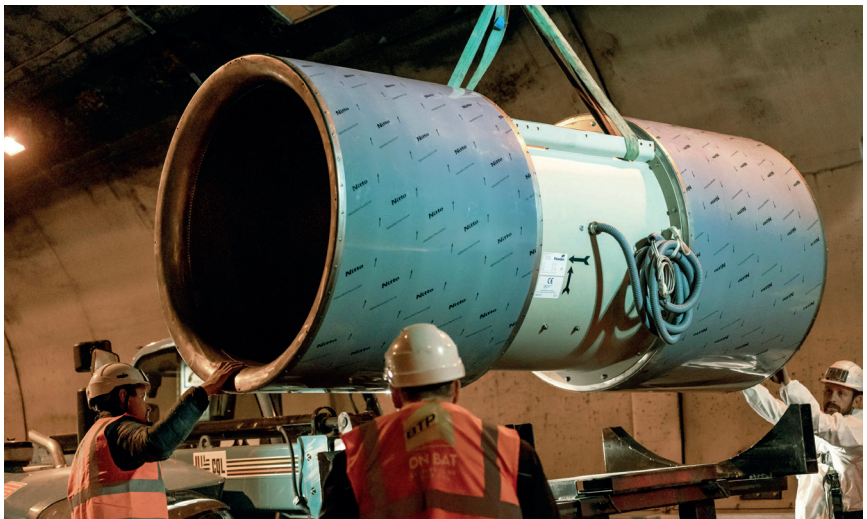
Rénovation de la ventilation du tunnel de la Grand'Mare (source DIR Nord-Ouest)
