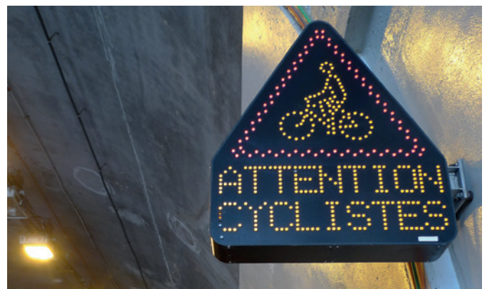
Panneau présence cycliste allumé après détection (© CETU)
