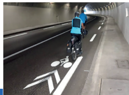
Marquage de positionnement pour les cyclistes (© CETU)
