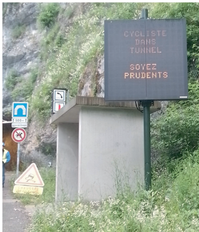
Message d'alerte de présence cycliste dans le tunnel des Écouges (tête nord) (© CETU)
