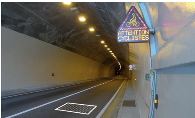
Boucle magnétique et bande cyclable (© CD26)
