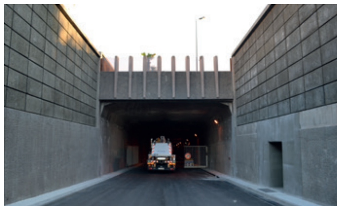
Figure 3d : Tête d'ouvrage précédée d'une trémie d'accès avec des murs antibruit
