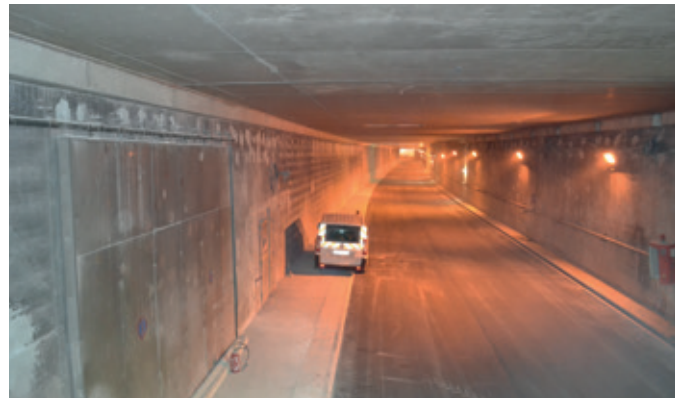
Figure 7d : Revêtement en béton armé [tranchée couverte]
