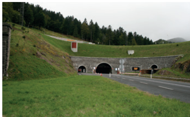
Figure 3c : Ouvrage de tête remblayé et supportant une route
