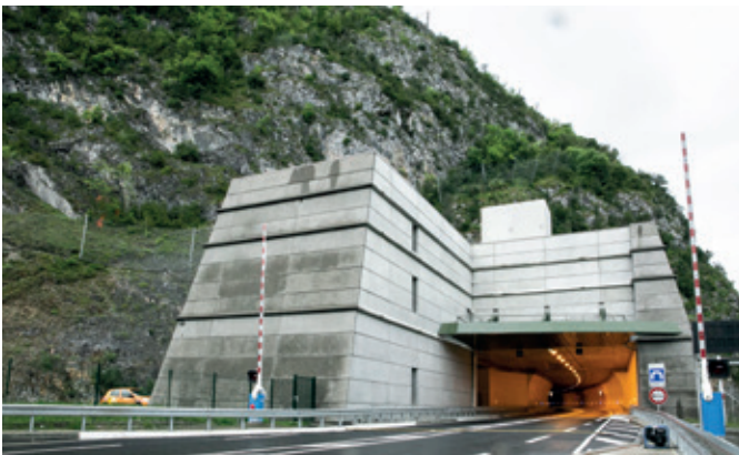
Figure 4b : Usine de ventilation en tête de tunnel
