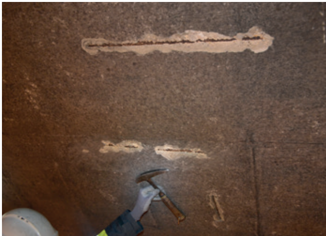
Illustration 10 : Fers apparents dans le revêtement après purge des éléments instables
