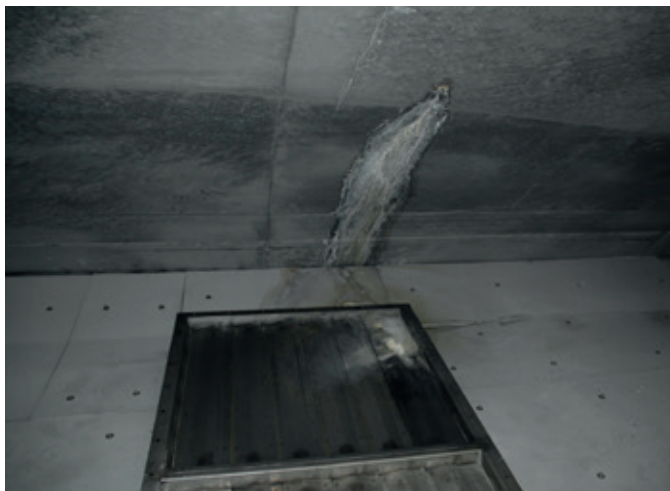
Figure 11a : Protections passives autour d'une trappe de désenfumage
