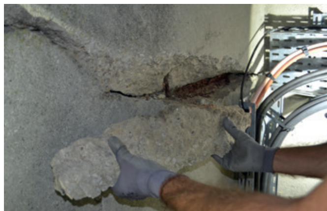
Illustration 9 : Écaille purgée sur fer oxydé
