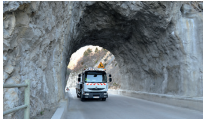
Figure 7c : Revêtement en béton projeté fibré [tunnel creusé]
