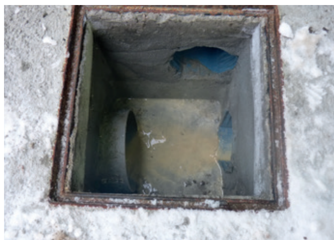
Illustration 15 : Regard d'accès à l'exutoire d'un drain d'intrados
