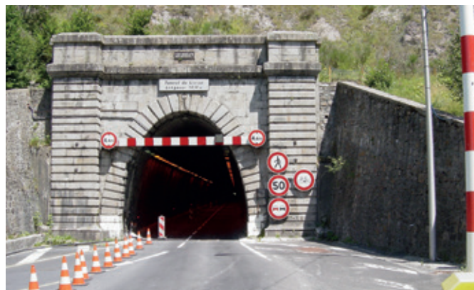
Figure 3a : Fausse-tête d'un tunnel en maçonnerie
