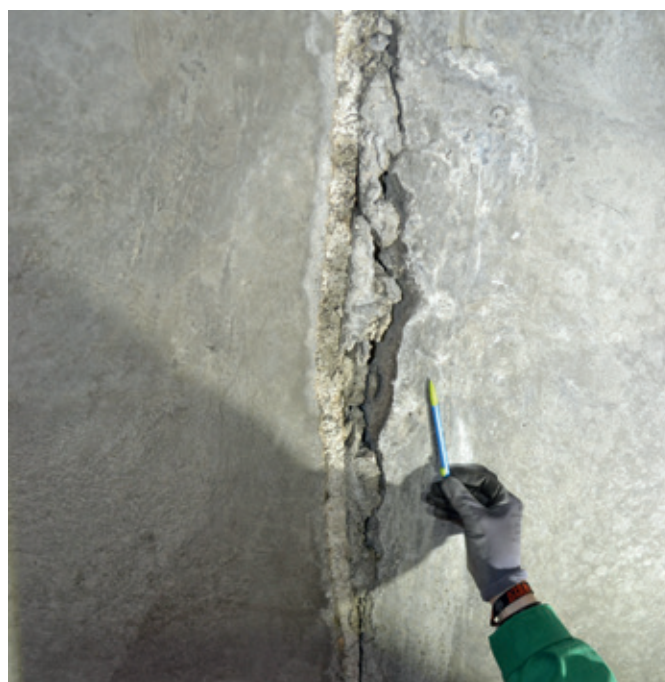
Illustration 8 : Écailles à purger dans un joint entre plots
