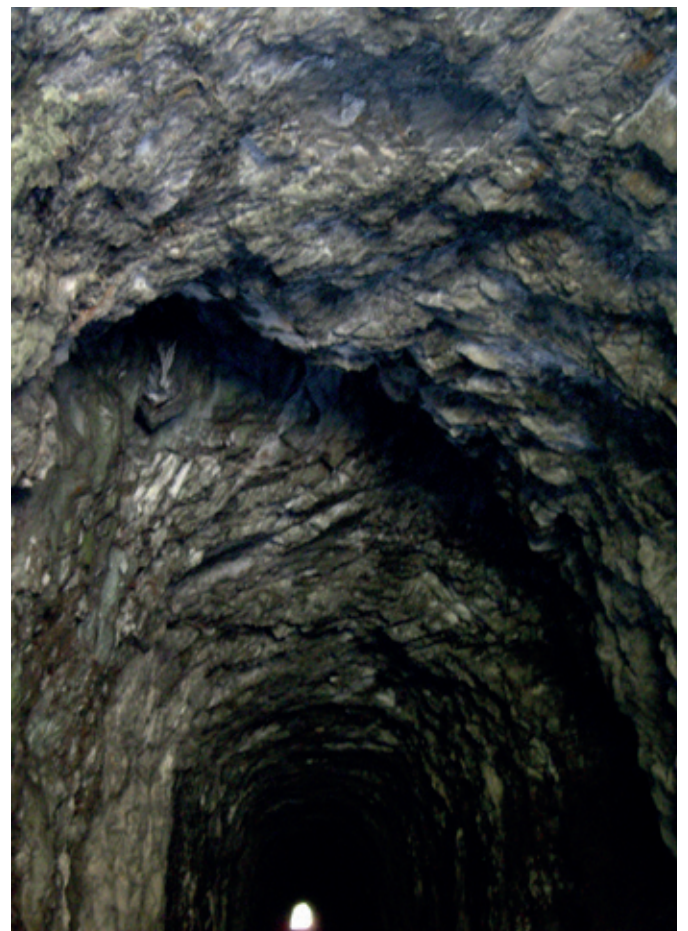
Figure 6 : Tunnel non revêtu
