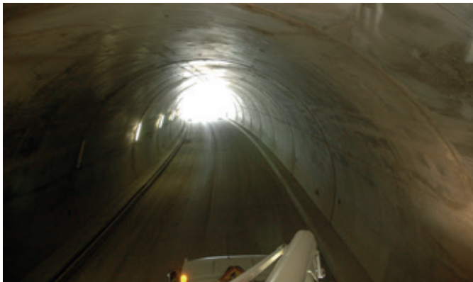
Figure 7a : Revêtement en béton non armé [tunnel creusé]
