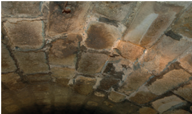
Figure 7b : Revêtement en moellons [tunnel creusé]
