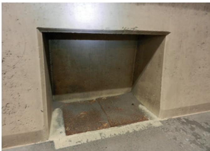
Illustration 12 : Niche d'accès aux drains d'extrados
