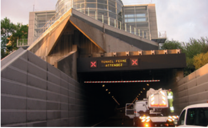
Figure 4a : PC de surveillance en tête de tunnel
