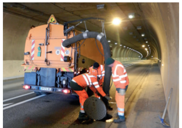
Illustration 3 : Nettoyage d'un regard
