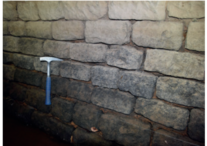
Illustration 11 : Maçonnerie de piédroit disjointoyée
