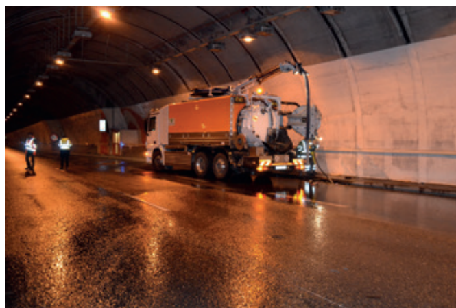
Illustration 14 : Hydrocurage en cours dans un tunnel
