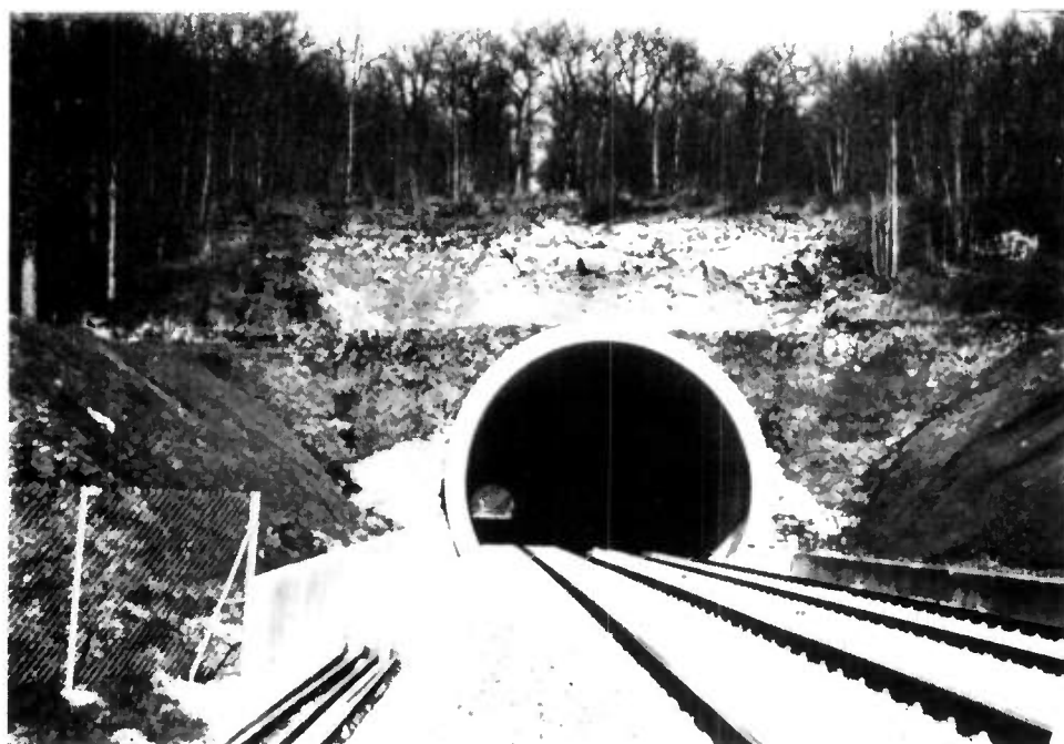
Figure n° 9. SNCF - Ligne Paris-Mulhouse. Tunnel de Marnay
