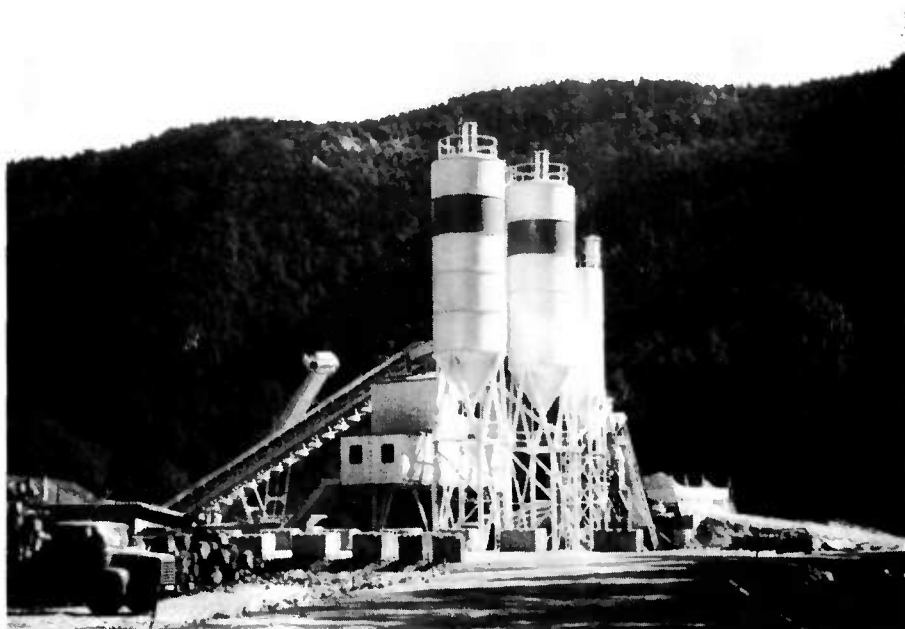
Figure 18. Autoroute A.40. Tunnel de Chamoise. Centrale de fabrication du béton tête Neyrolles.
