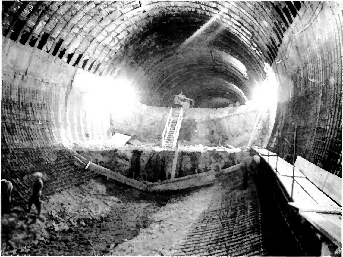
Figure n° 5. Autoroute A 8 - Tunnel du Col de Guerre. Ferrailage en cours de la contre-voûte et des piédroits
