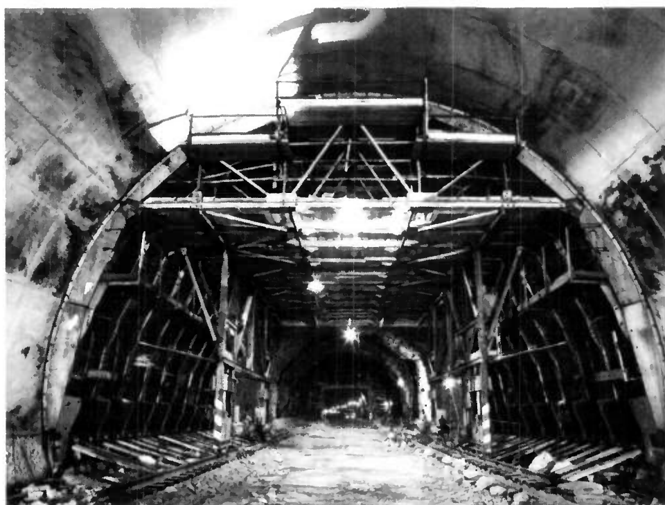
Figure 21. Autoroute A. 8. - Tunnel du Col de l'Arme.
