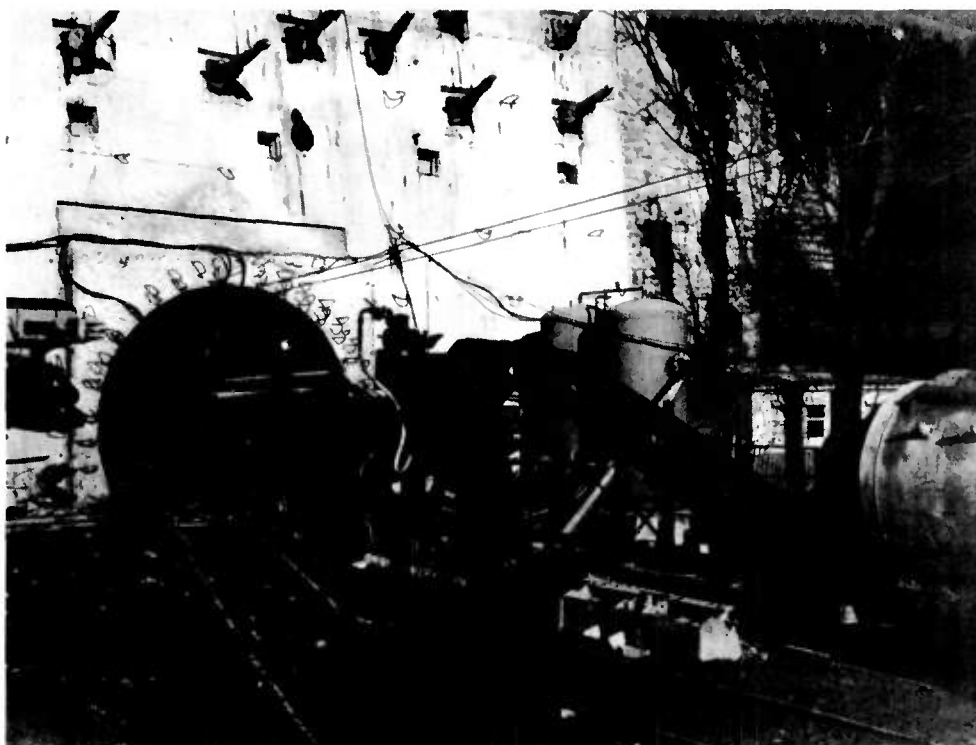
Figure 36. Galerie technique sous Fourvière - Lyon. Train pour injection de remplissage.
