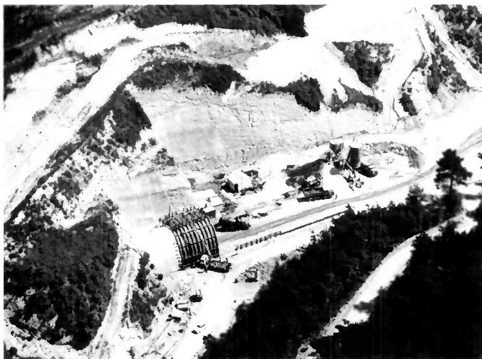
Figure 33. Autoroute A. 8. - Tunnel de Pessicart - Bétonnage de la casquette du tube Nord - Tête Ouest.
