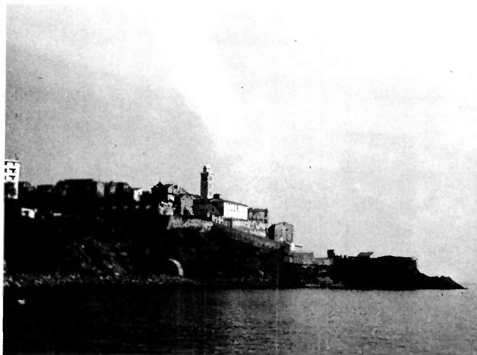
Figure 37. Tunnel sous la Citadelle - Bastia.
