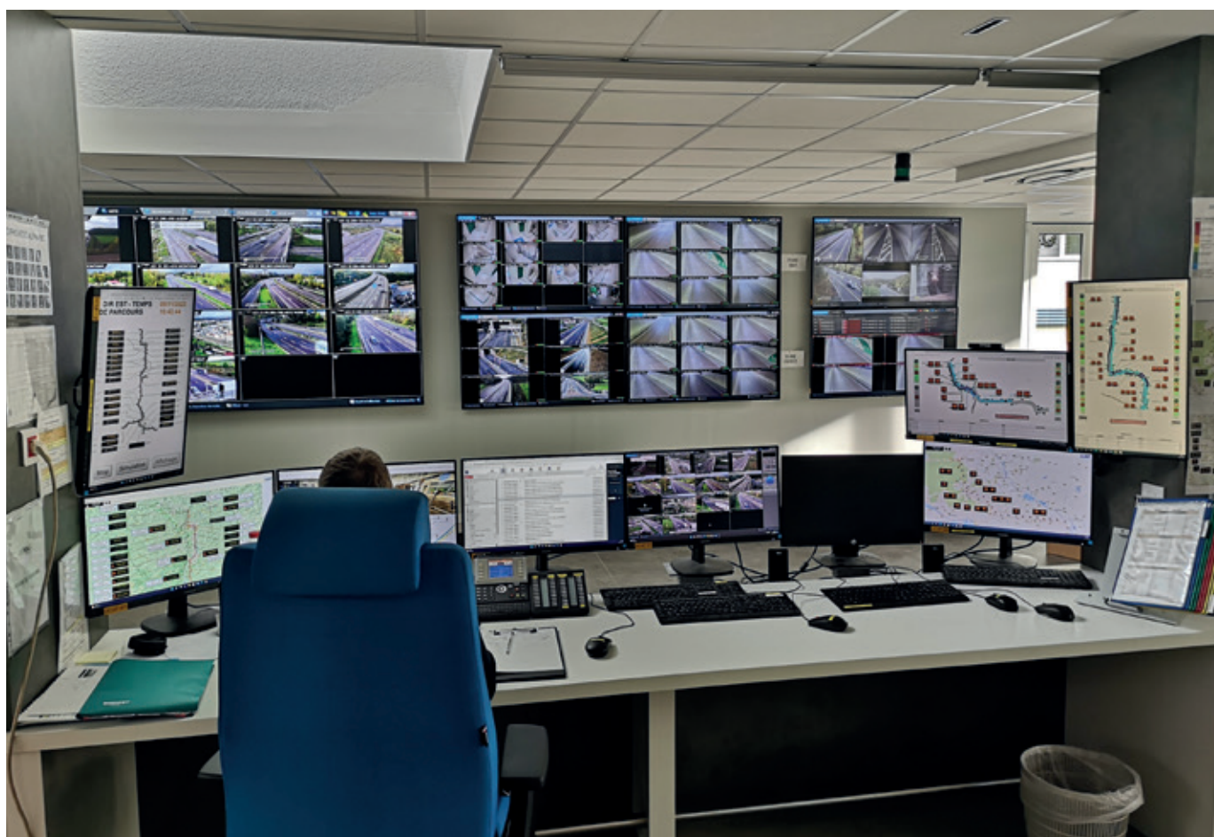
Figure 1 : Mur d'images du Poste de Contrôle Commande du Centre d'Ingénierie de Sécurité et de Gestion du Trafic de Moulin-les-Metz
