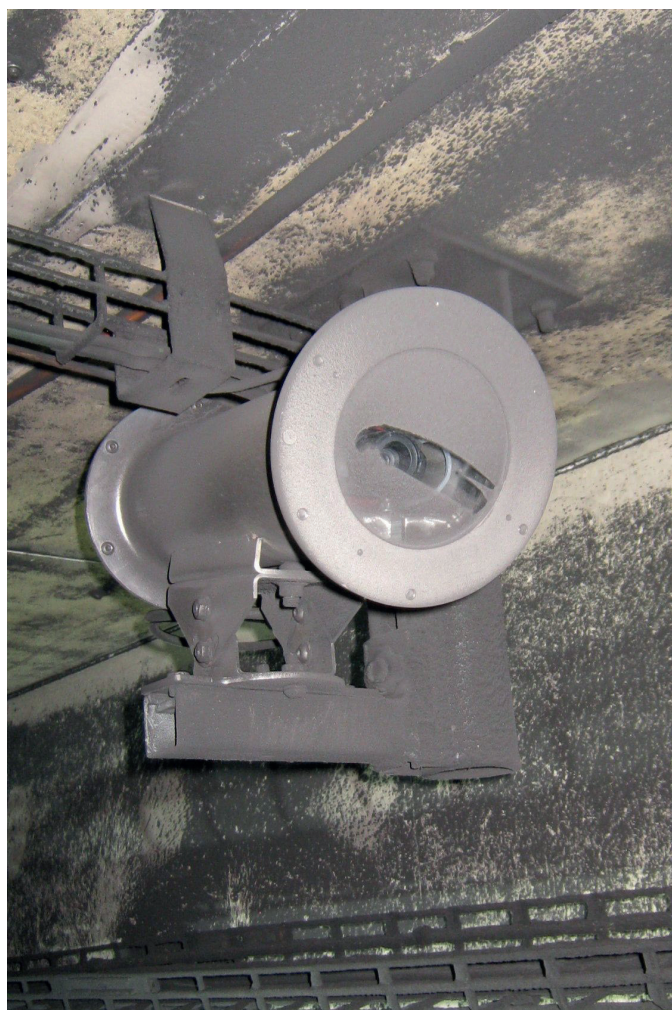
Figure 15 : Encrassement d'une vitre de caisson de caméra DAI
