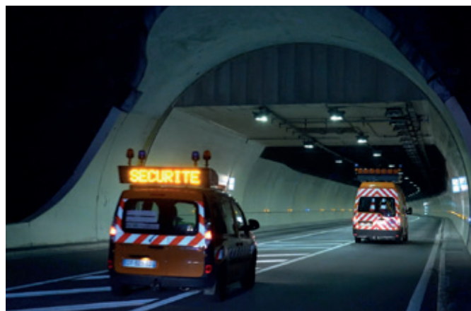
Tunnel du Siaix – Exercice de sécurité 2024 (© DIRCE)
