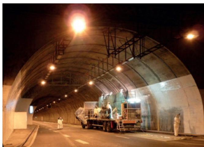
Tunnel du Rond-Point – Travaux de peinture (© CETU)
