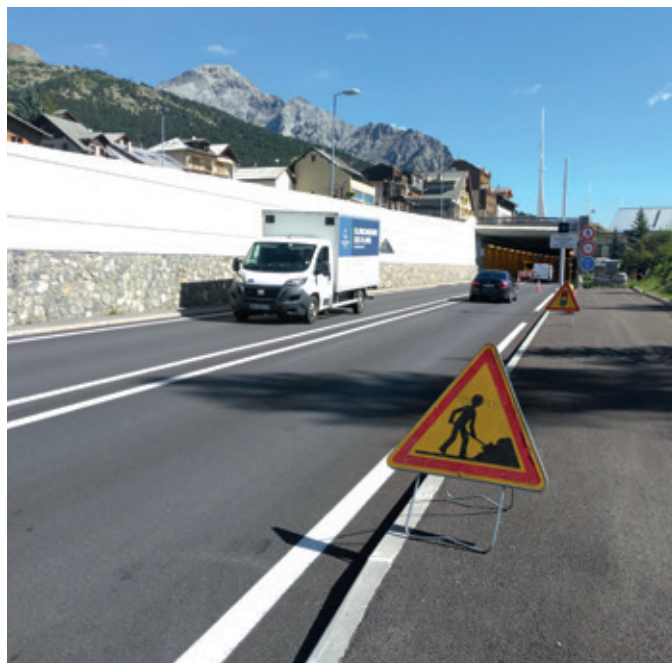
Tranchée couverte de Montgenèvre (© DIRMED)
