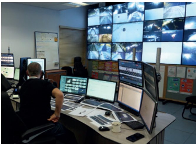
Tunnel du Siaix – Exercice de sécurité 2024 (© DIRCE)
