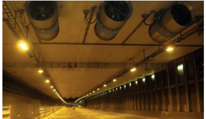
Tunnel de Champigny (© CETU)
