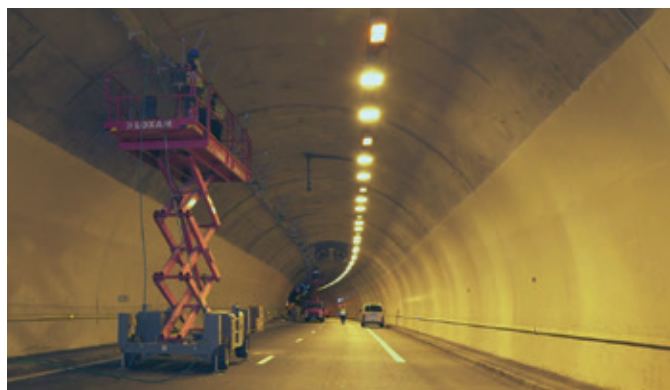
Tunnel du Pas de l'Escalette – Travaux (© DIRMC)
