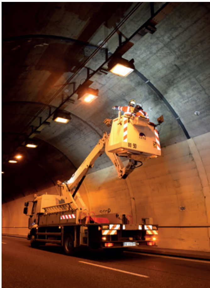
Tunnel du Rond-Point – Inspection détaillée périodique de génie civil (© CETU)
