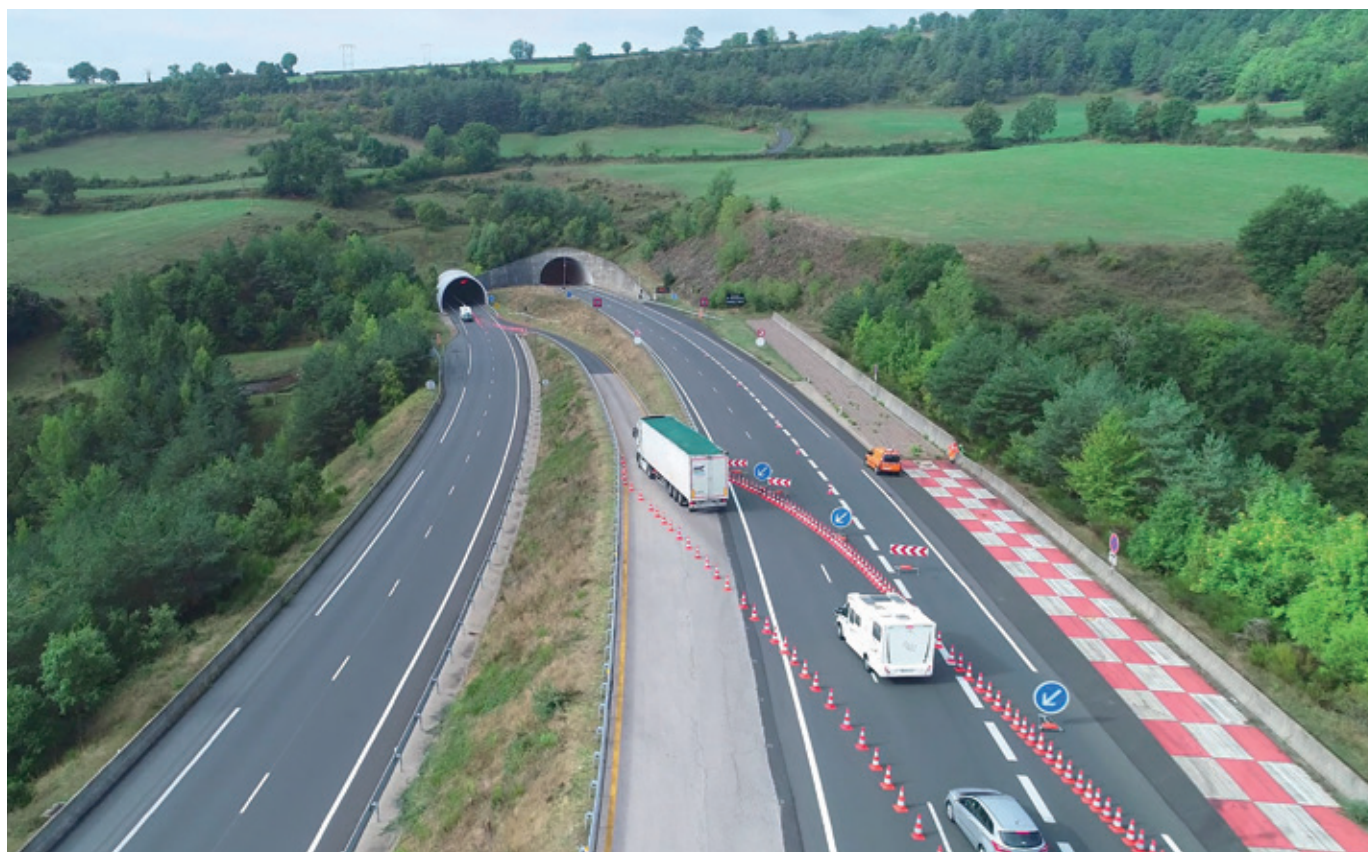
Entrée du tunnel de Montjézieu (© DIRMC)
