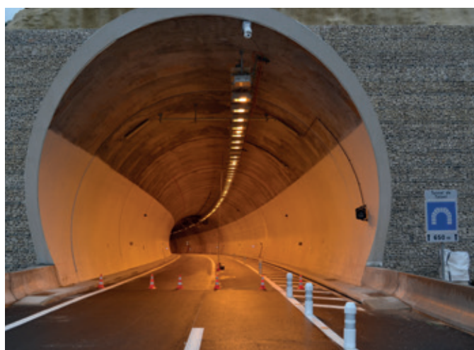
Tunnel de Talant (© CETU)
