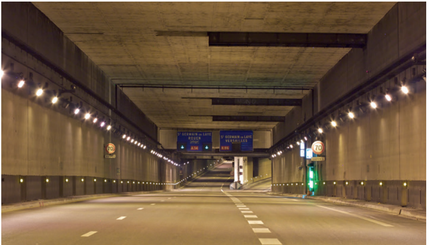
Tunnel de la Défense (© CETU)
