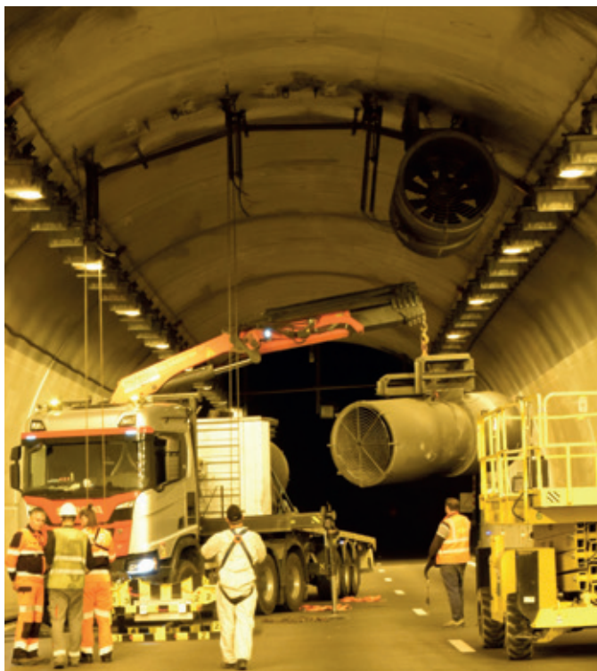
Tunnel des Monts – Dépose d'un accélérateur (© CETU)
