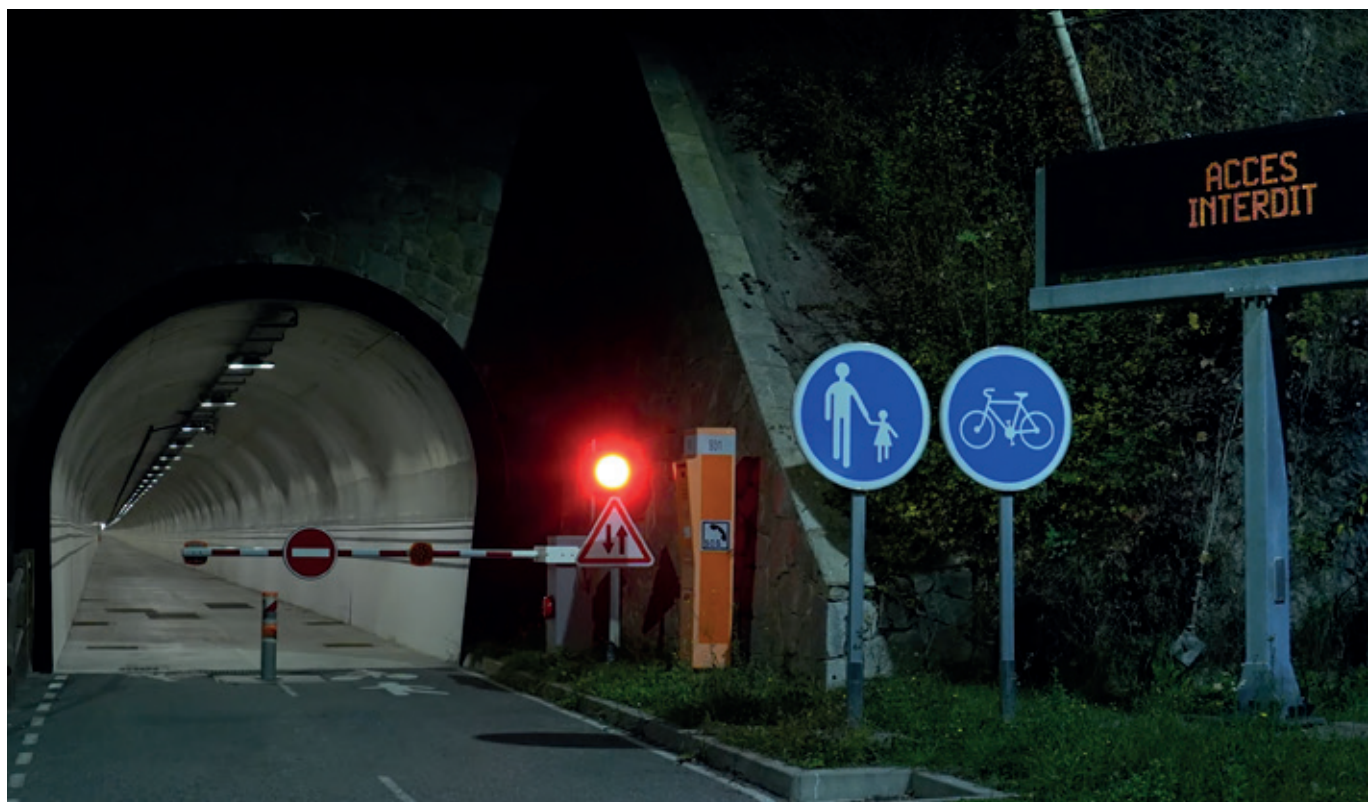
Tunnel du Siaix – Exercice de sécurité 2024 (© DIRCE)
