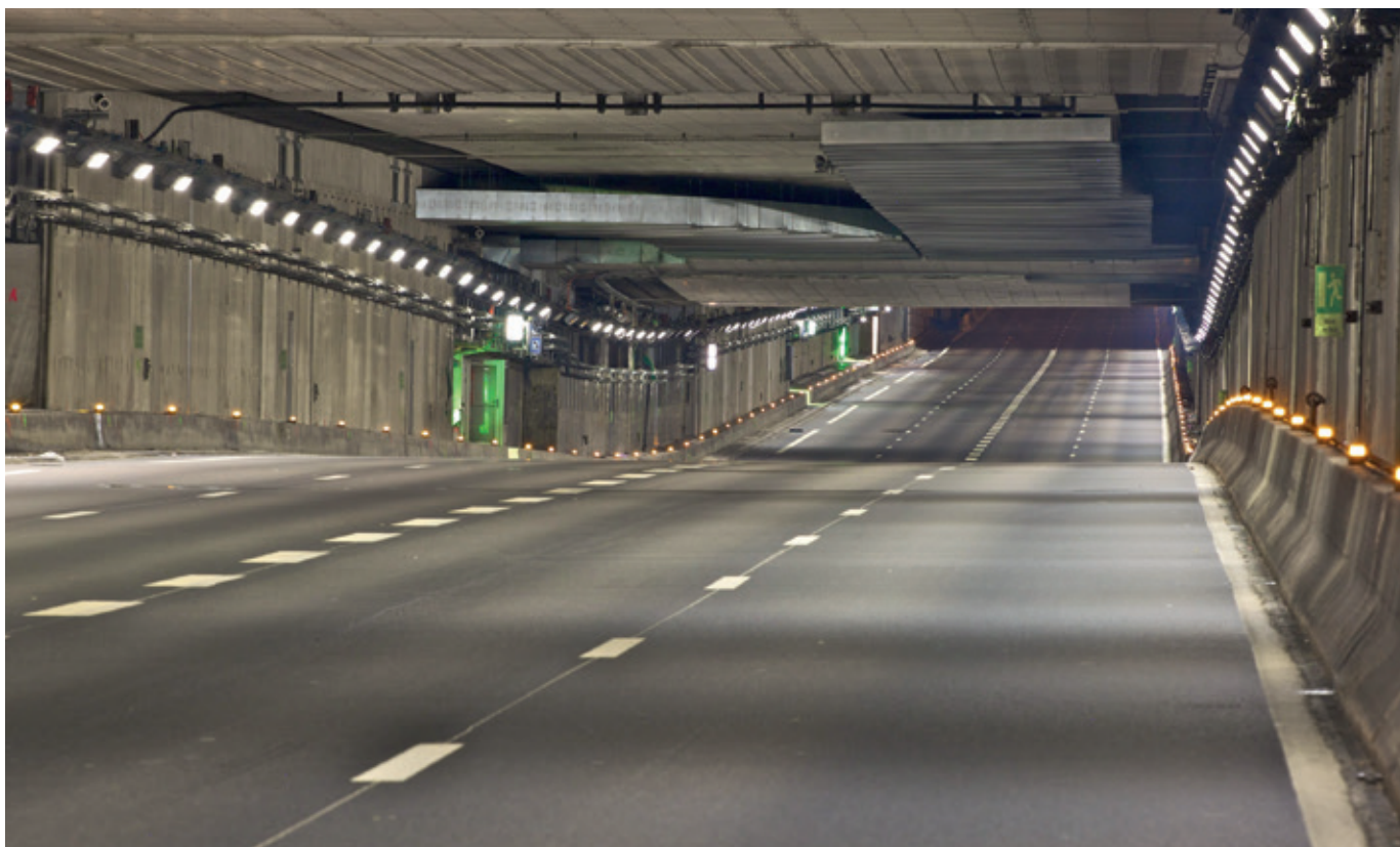
Tunnel du Landy (© CETU)
