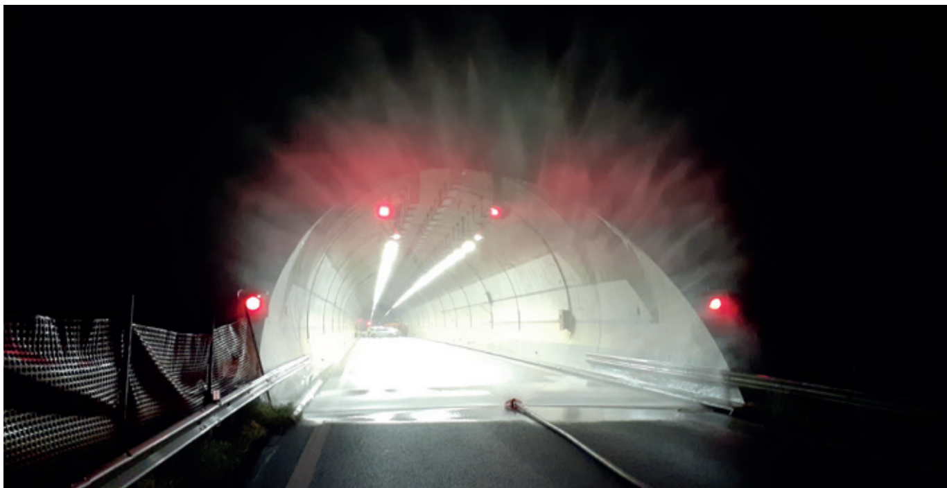
Entrée du tunnel de Noailles (© DIRCO)
