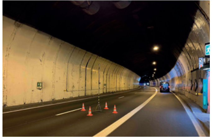
Tunnel de Saint-Cloud (© CETU)
