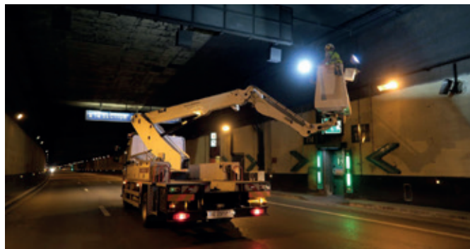
Complexe A14/A86 – Inspection détaillée périodique des équipements (© CETU)
