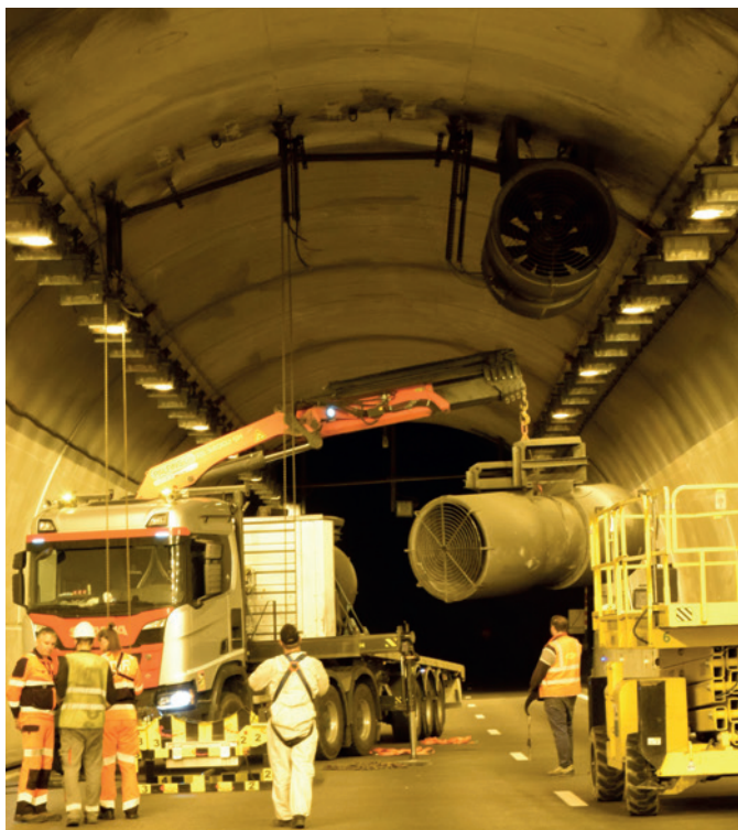
Tunnel des Monts – Dépose d'un accélérateur (© CETU)
