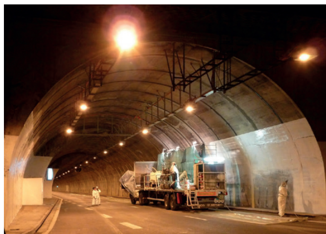
Tunnel du Rond-Point – Travaux de peinture (© CETU)
