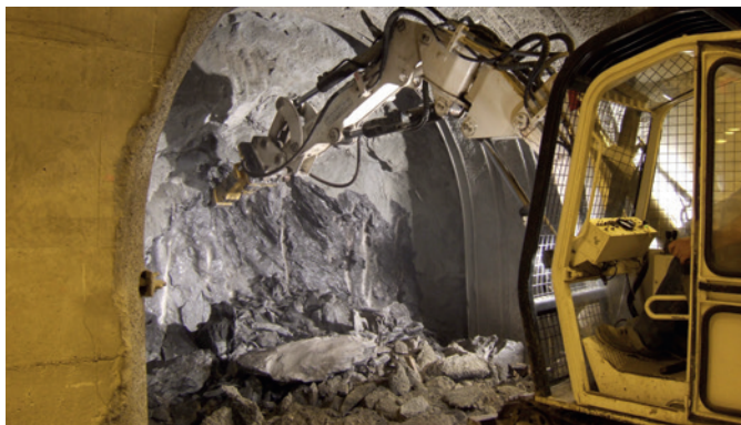
Tunnel du Rond-Point – Travaux de percement d'un intertube (© CETU)
