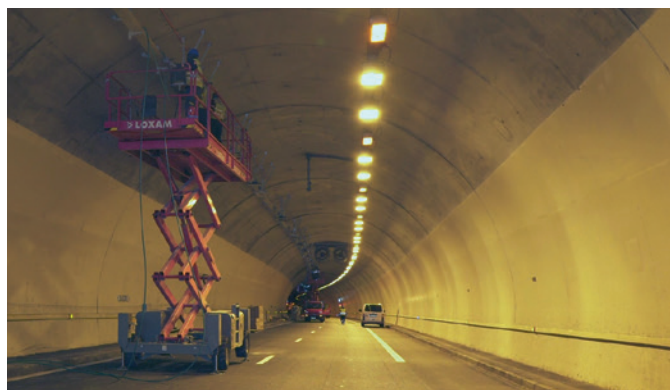
Tunnel du Pas de l'Escalette – Travaux (© DIRMC)
