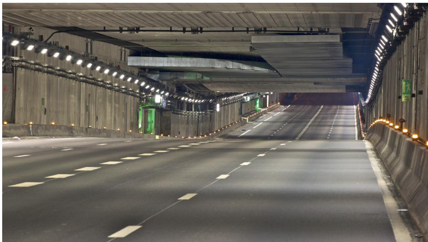
Tunnel du Landy (© CETU)
