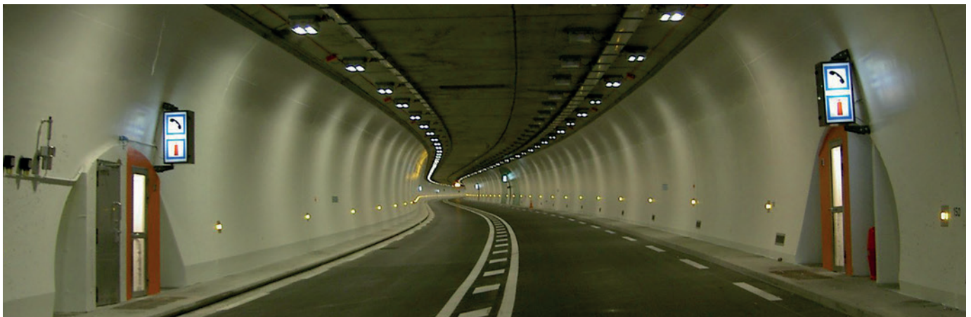
Tunnel du Lioran (© CETU)
