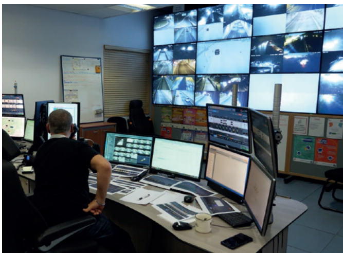
Tunnel du Siaix – Exercice de sécurité 2024 (© DIRCE)
