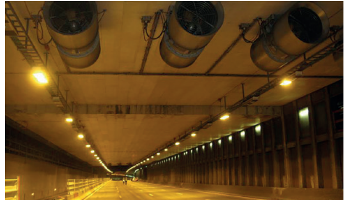
Tunnel de Champigny (© CETU)
