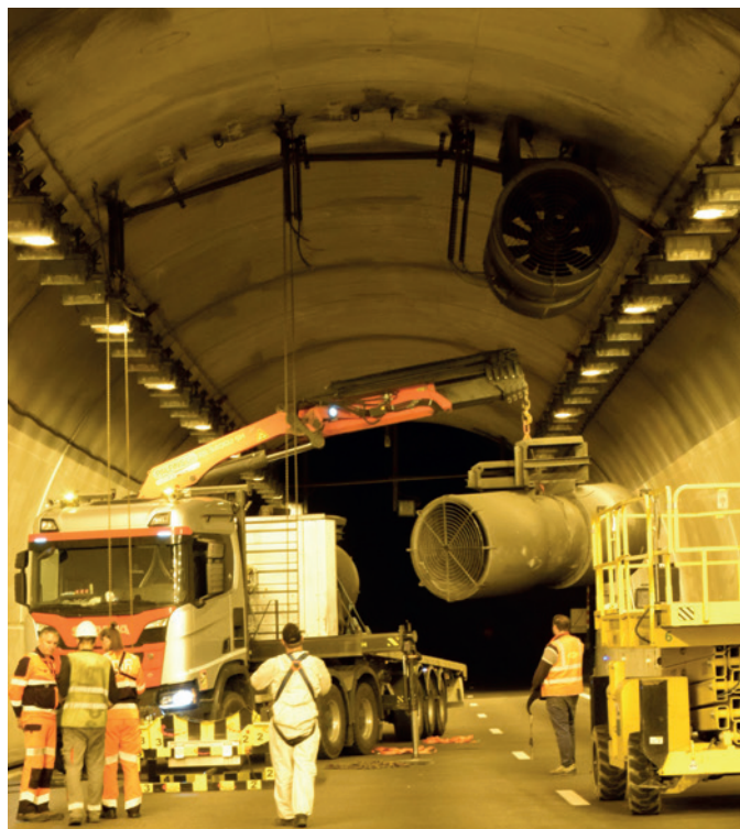
Tunnel des Monts – Dépose d'un accélérateur (© CETU)
