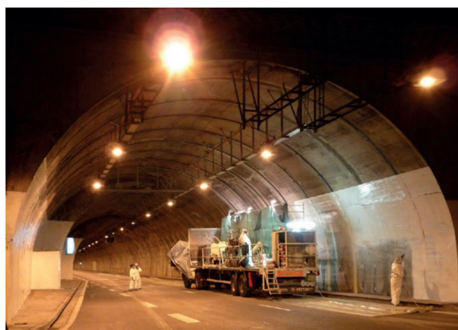
Tunnel du Rond-Point – Travaux de peinture (© CETU)
