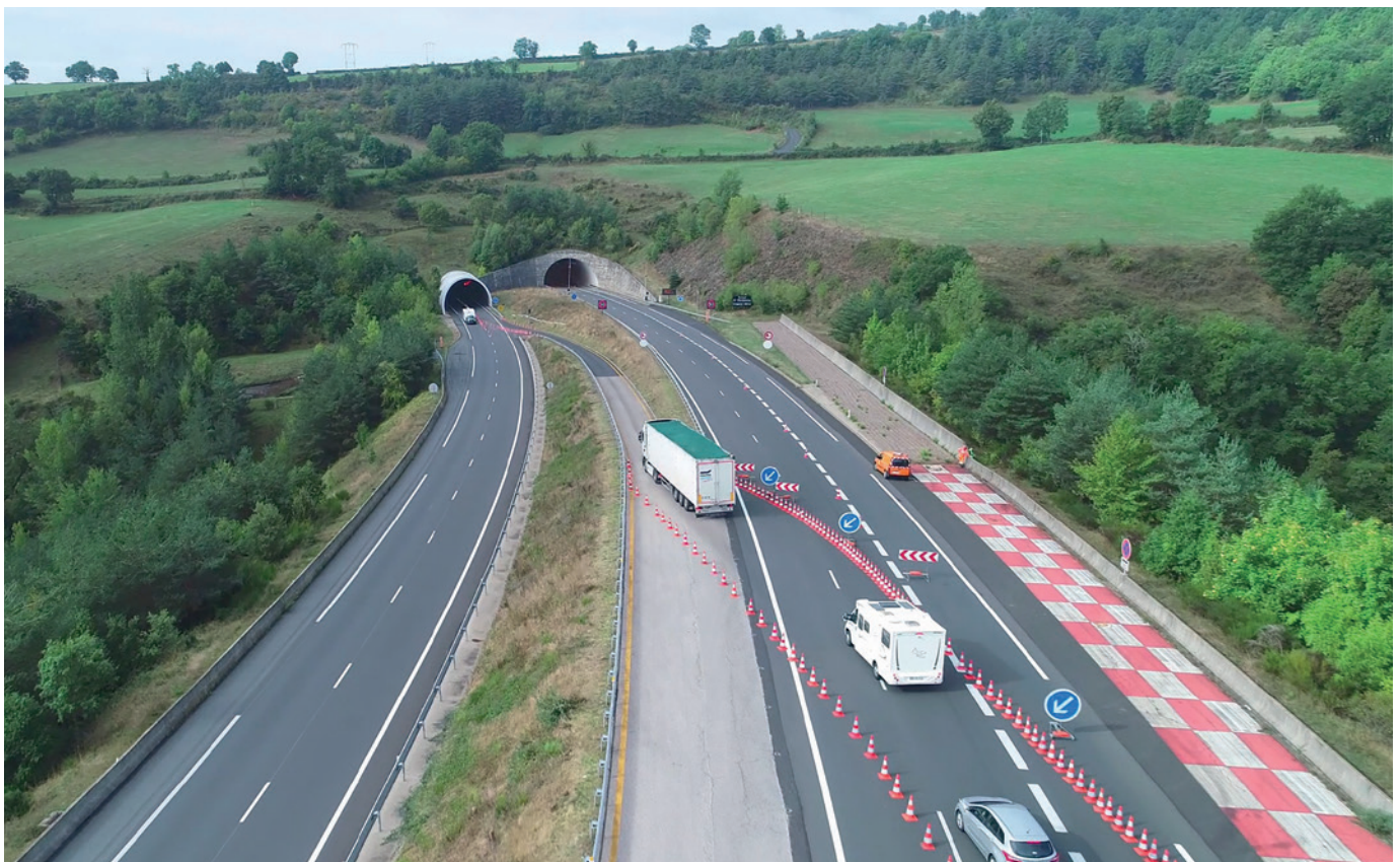
Entrée du tunnel de Montjézieu (© DIRM C)
