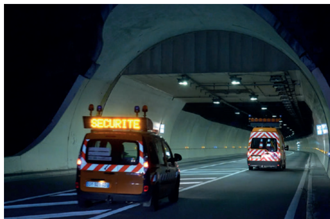
Tunnel du Siaix – Exercice de sécurité 2024 (© DIRCE)
