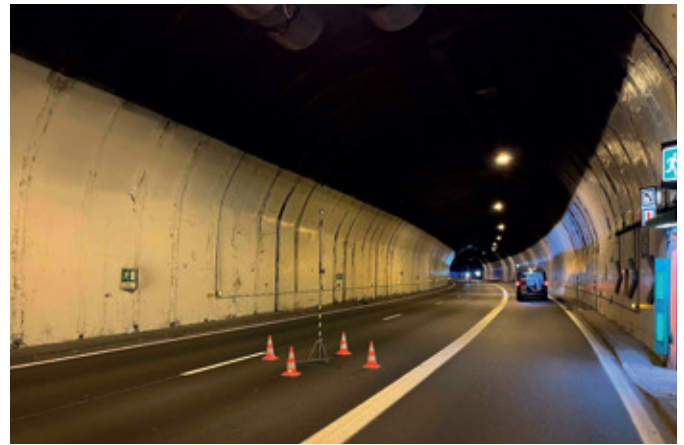
Saint-Cloud Tunnel (© CETU)
