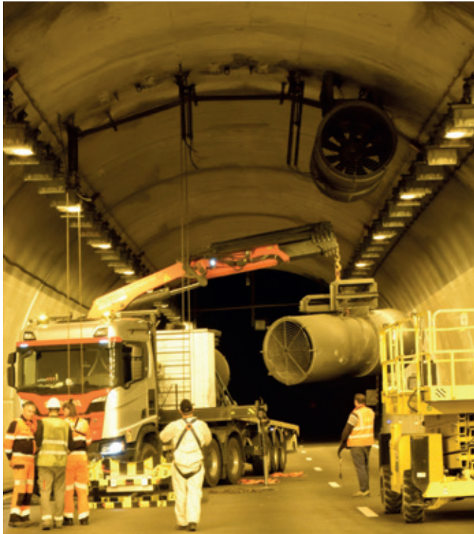
Tunnel des Monts – Removal of a jet fan (© CETU)
