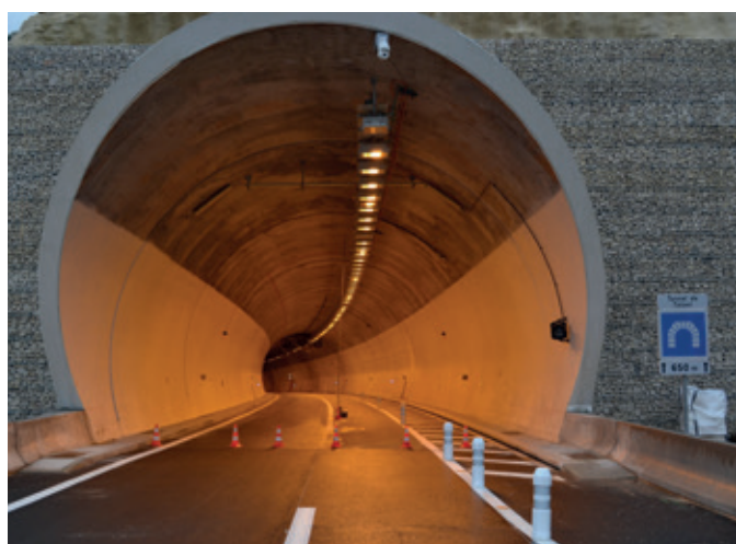
Talant Tunnel (© CETU)
