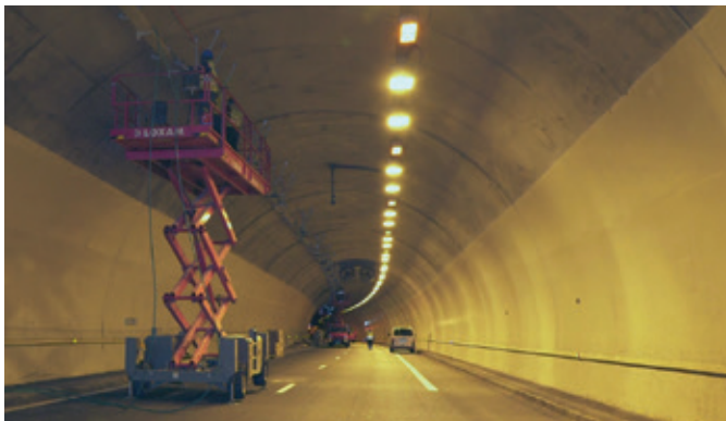
Pas de l'Escalette Tunnel – Works (© DIRM)
