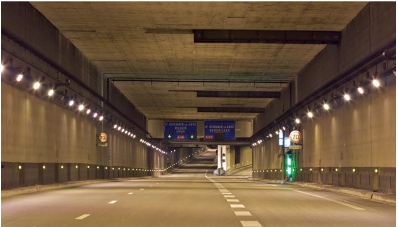
La Défense Tunnel (© CETU)
