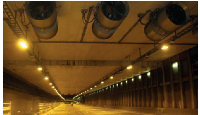
Champigny Tunnel (© CETU)
