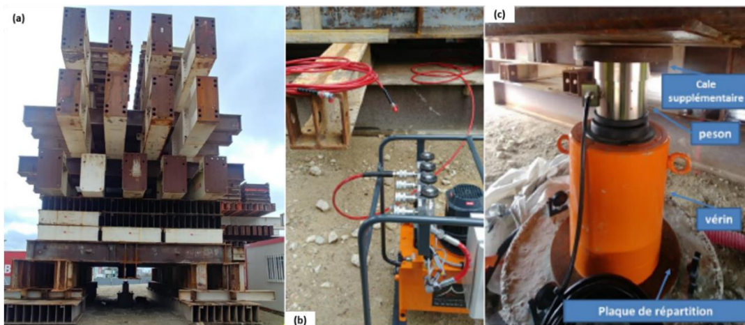
Figure 2-11 : Système de chargement des pieux (Mohamad, 2022)
