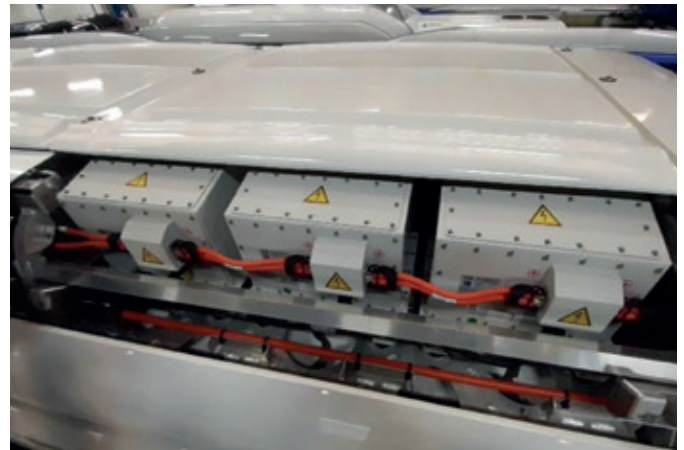
Figure 15 : Batteries sur un bus électrique
