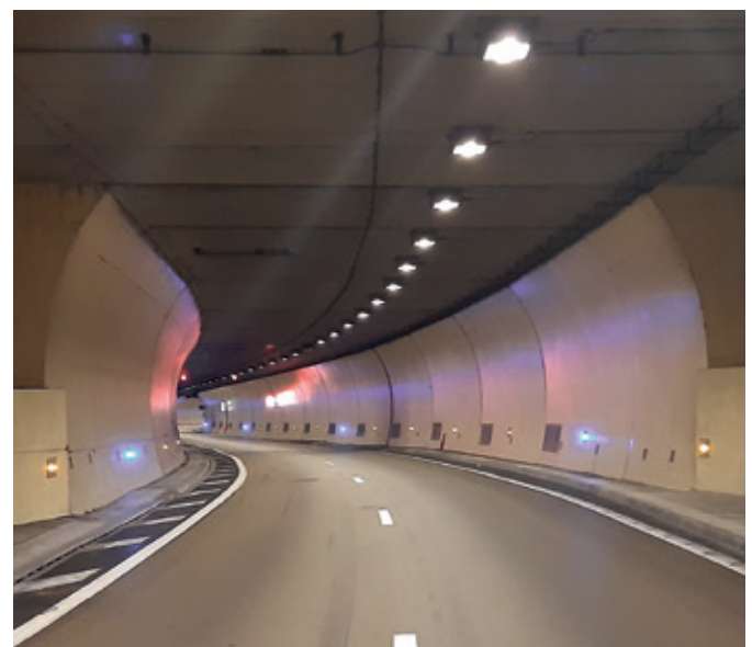
Tunnel de Toulon après traitement – Source : Vinci Autoroute
