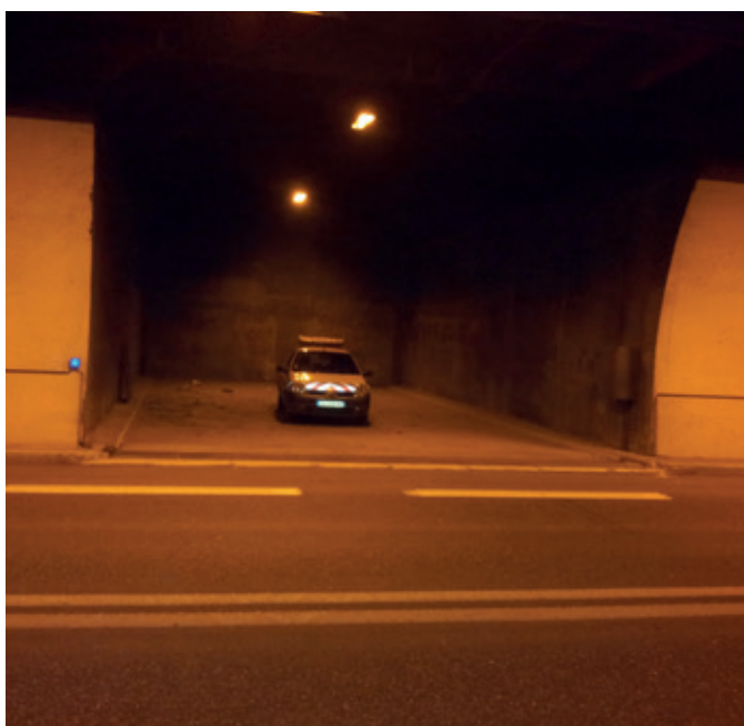
Tunnel de Siaix avant – Source : DIRCE
