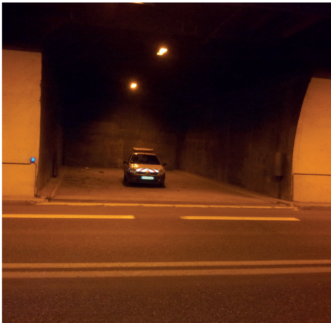
Tunnel de Siaix avant – Source : DIRCE
