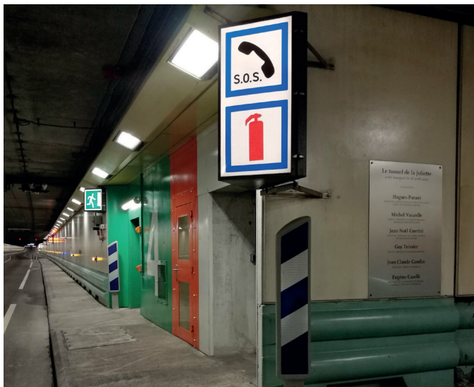
Tunnel de la Joliette – Source : BG Ingénieurs Conseils
