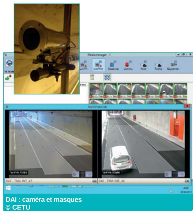
Elle a ainsi rappelé que, compte tenu de l'importance de minimiser le délai d'alerte en cas d'incendie, la détection de fumées est une fonction essentielle de la DAI, qui ne peut pas être remplacée par la simple remontée d'une alarme technique de perte de visibilité. Une autre fonction essentielle est la détection de véhicules arrêtés car il s'agit souvent du premier signe de la présence d'une situation anormale dans l'ouvrage, ce qui permet de gagner du temps en cas d'événement grave.
