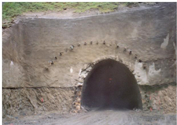
Dégagement de la tête construite à l'air libre et mise en place d'une voûte parapluie en tubes pétroliers
