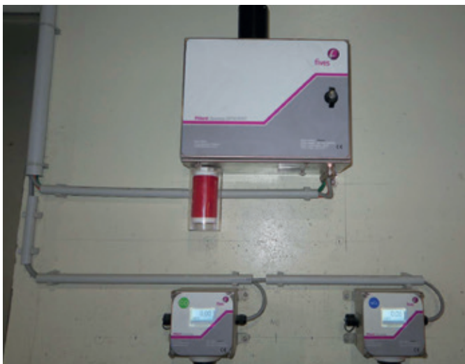
Illustration 17 : Opacimètre (en haut), appareil de mesure du dioxyde d'azote (en bas à droite) et du monoxyde de carbone (en bas à gauche) (crédit photo : CETU)
