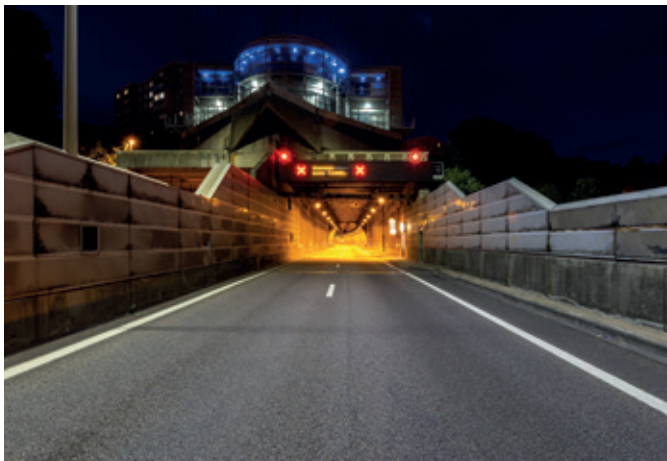
Illustration 1 : Tête sud du tunnel de la Grand'Mare (crédit photo : DIR Nord-Ouest)
